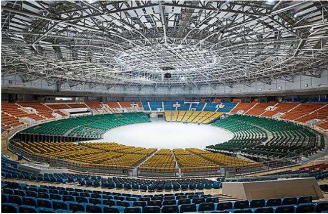
Figura 19. Cable Dome costruita per la copertura dell'arena di Seoul
