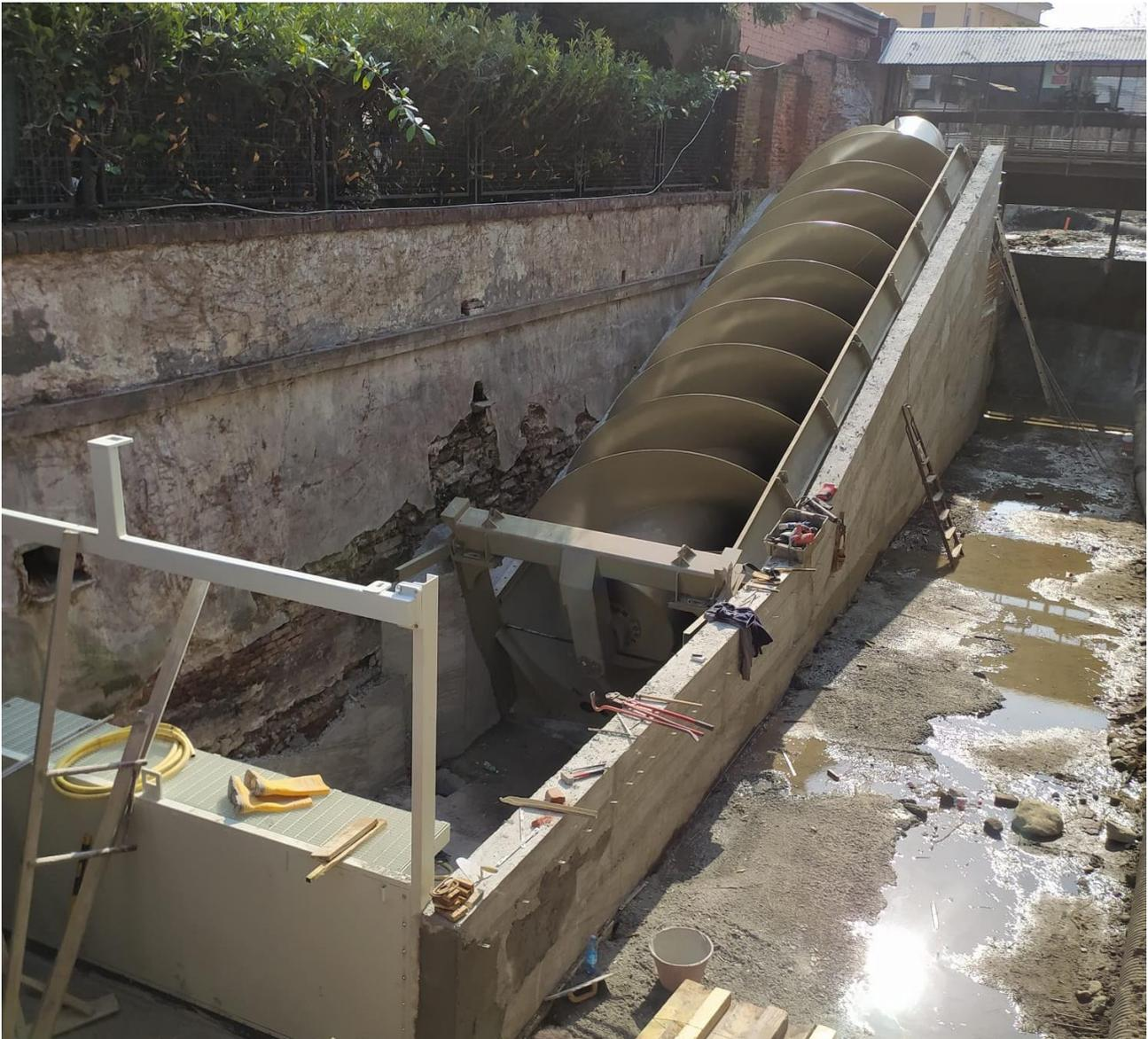
*Figura 3 Fase di installazione della macchina sull'impianto "Mustad" a Pinerolo*
