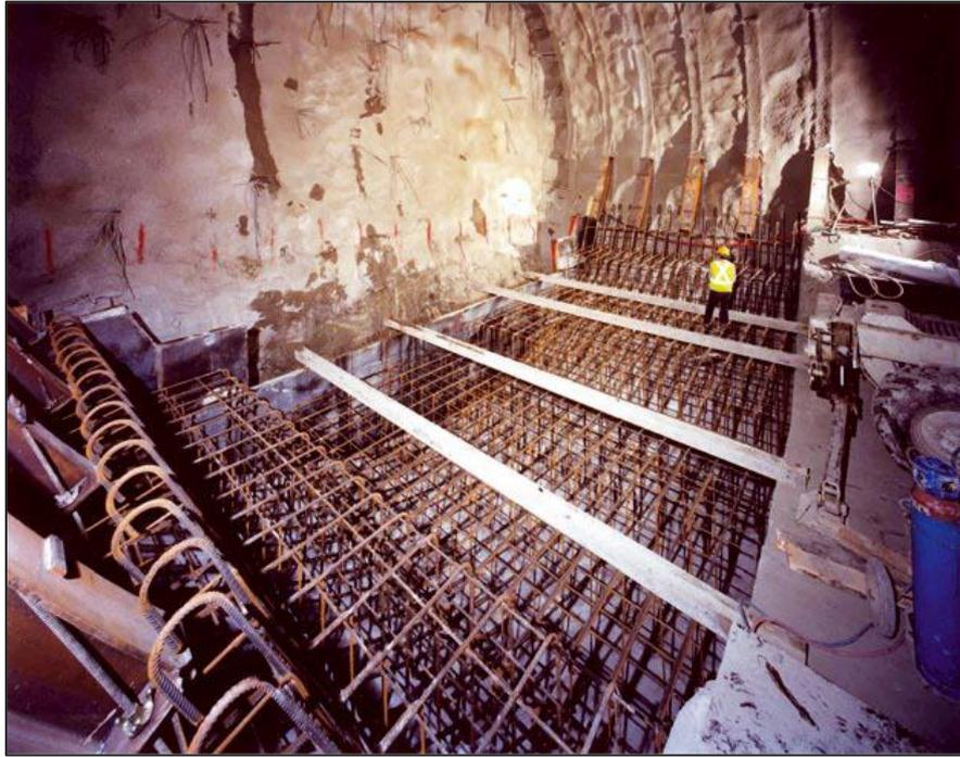
Figura 1.31: Armatura dell'arco rovescio (galleria Tartaignille) (Lunardi, 2006)
