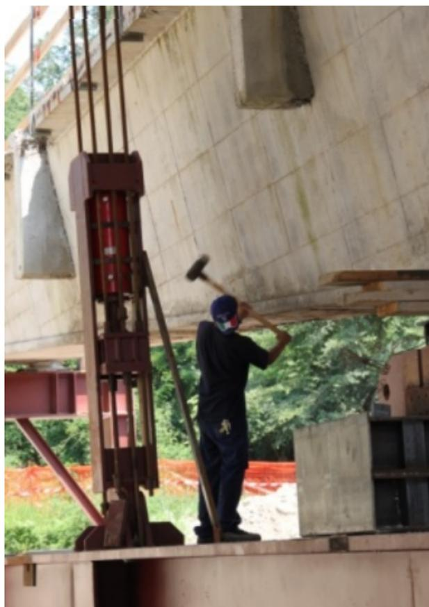
Figura 3.8. Possibile utilizzo di un martello battente
