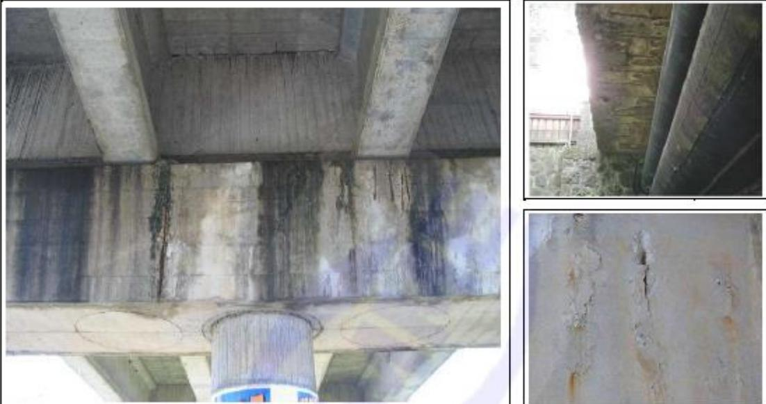
Fig. 3.1 - Porzione di una Scheda Difettologica relativa a calcestruzzo dilavato e ammalorato<sup>1</sup>.
