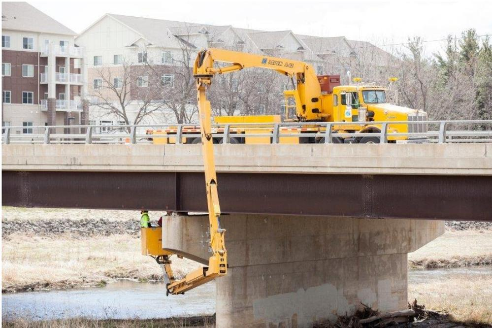
Fig. 2.1 – Ispezione dell’impalcato eseguita mediante veicolo con braccio meccanico<sup>1</sup>.
