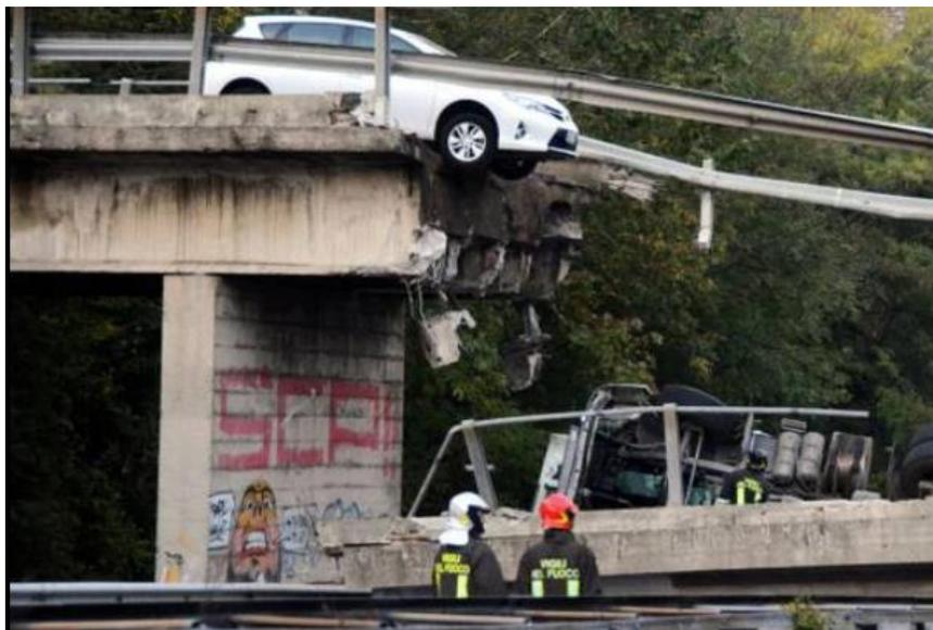
Figura 1.2: Dettaglio a collasso avvenuto della campata centrale del cavalcavia di Annone <sup>10</sup>.
