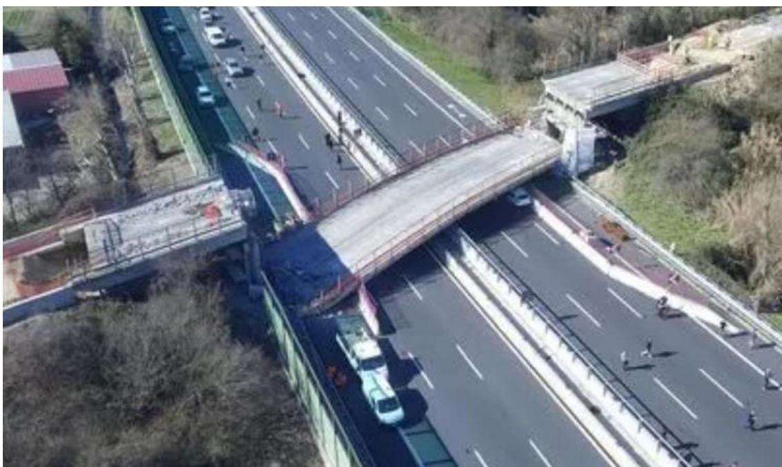
Figura 1.3: Dettaglio a collasso avvenuto della campata centrale del cavalcavia dell'autostrada A14 sull'adriatica<sup>12</sup> .
