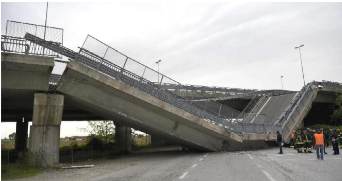
Figura 1.4: Dettaglio a collasso avvenuto del viadotto della tangenziale Fossano in provincia di Cuneo<sup>13</sup>.
