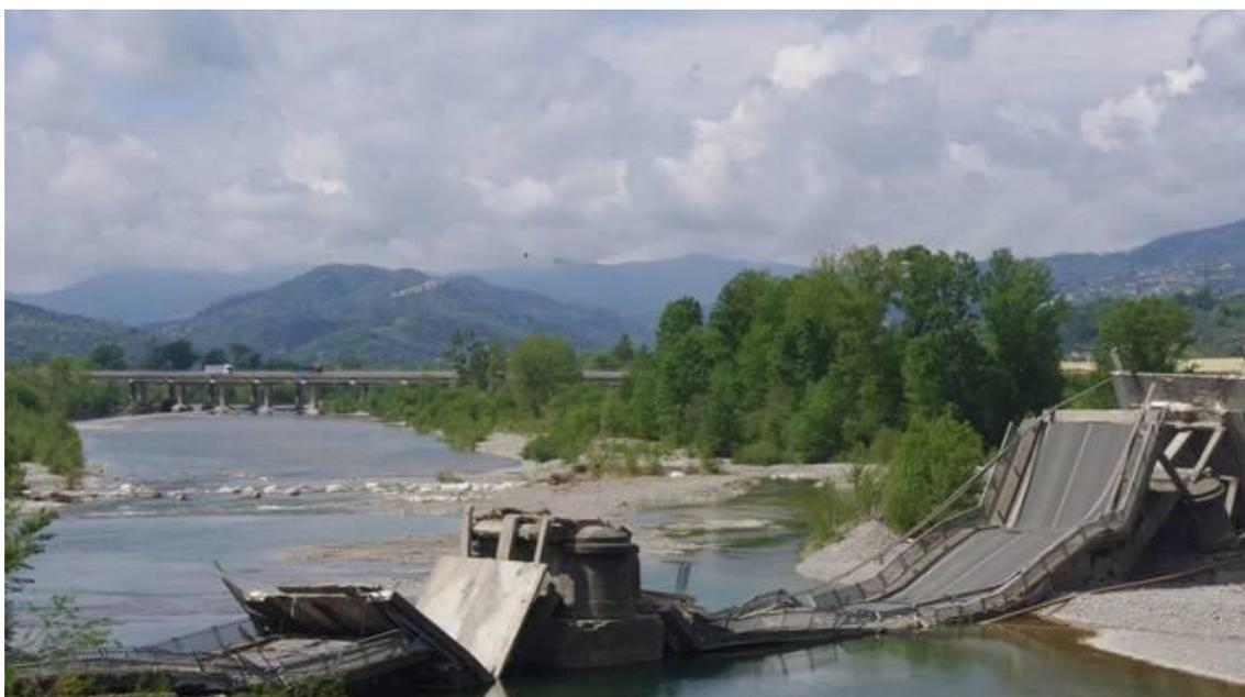
Figura 1.5: Dettaglio a collasso avvenuto del ponte Aulla di Caprigliola situato sulla ex strada provinciale 70, in provincia di Massa Carrara <sup>18</sup> .
