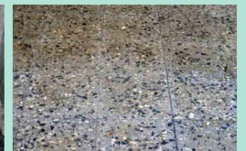
Il pavimento in piastrelle di graniglia di cemento (*marmittom*), all'interno del PG 016.
