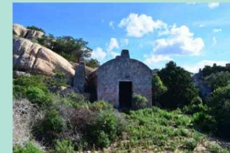
PG 010 e PG 011 in muratura mista con copertura a volta in calcestruzzo, internamente ed esternamente, e dettagli in calcestruzzo utili alla mimetizzazione. Entrambi i fabbricati sono dotati di *Gabbia di Faraday*.
