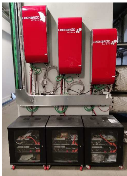
Figura 2-10: Parete con Inverter e batterie
