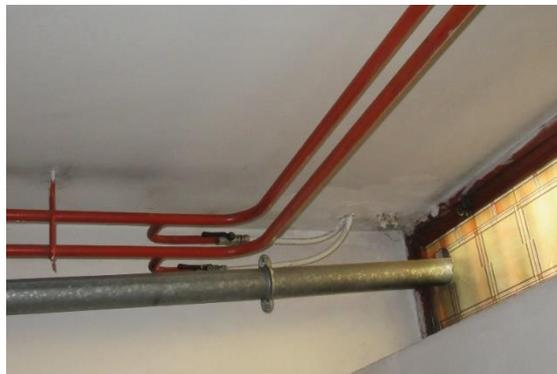
Figura 62 – Rete orizzontale di distribuzione sita all'interno del piano interrato
