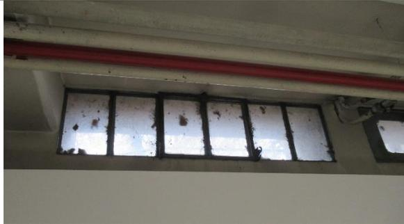
Figura 32 –Esempi di serramenti in ferro presenti nell'edificio scolastico
