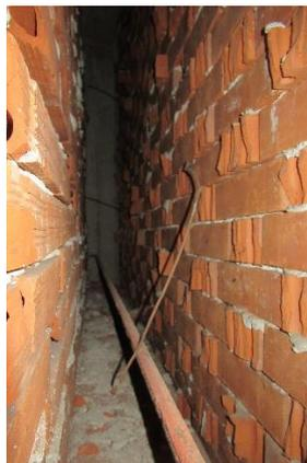
Figura 13 –Dettaglio stratigrafia tamponamento opaco palestra
