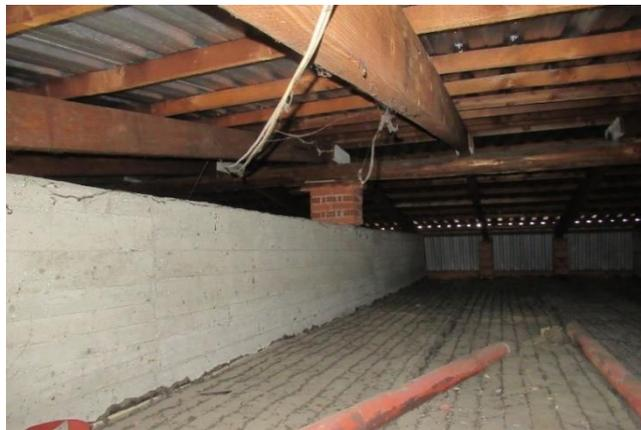
Figura 56 - Dettaglio del solaio su sottotetto della porzione aggiunta più di recente con strato coibente
