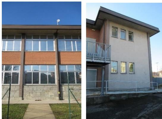
Figura 55 – Esempio delle diverse finiture delle superfici opache verticali della struttura (a sinistra: in basso finitura in pietra, in alto finitura in paramano; a destra finitura in intonaco)
