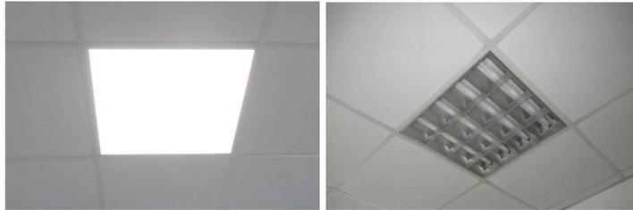
Figura 18 – Esempio di sorgente luminosa di tipo a LED (sinistra) e a plafoniera con tubi a fluorescenza (destra)
