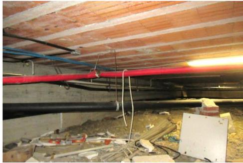
Figura 27 – Solaio di separazione verso gli ambienti seminterrati non riscaldati
