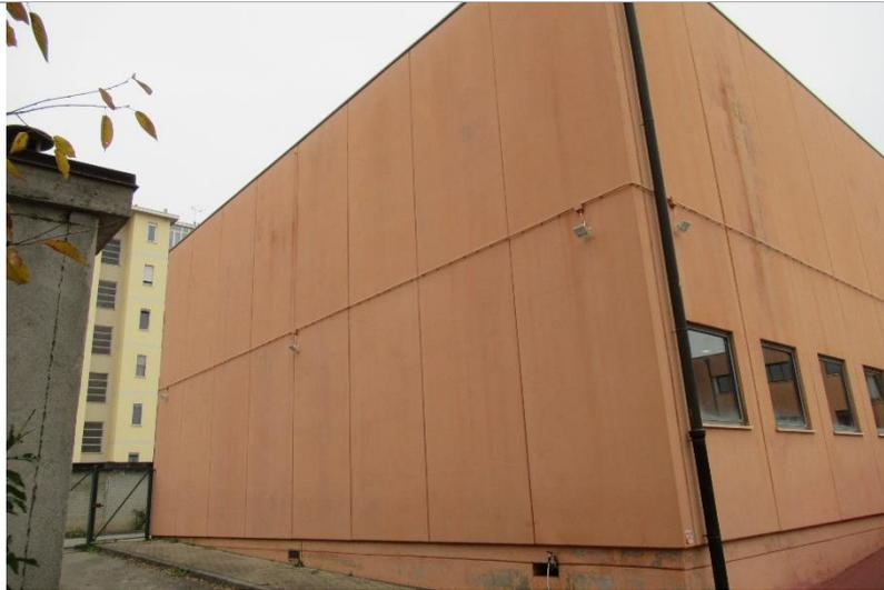
Figura 36 – Esempio di muratura in elementi prefabbricati (porzione laterale della palestra)
