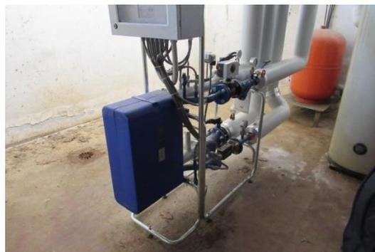
Figura 28 – Scambiatore di calore presente in centrale termica
