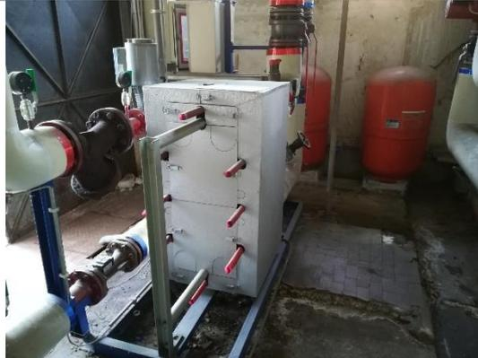
Figura 57 – Fotografia scambiatore presente in centrale termica
