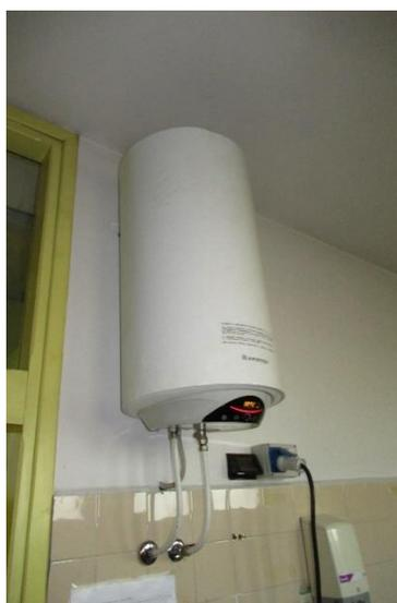
Figura 48 – Esempio di un bollitore elettrici presente nell'edificio scolastico
