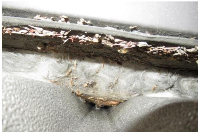
Figura 31 - Dettaglio del coibente presente all'estradosso al solaio di copertura dell'ambiente refettorio
