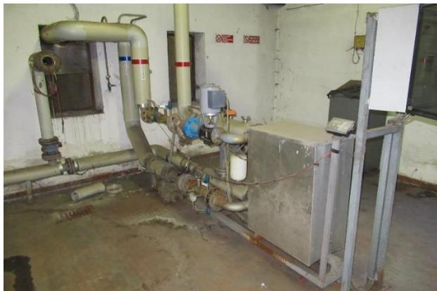
Figura 47 –Fotografia dello scambiatore presente in centrale termica
