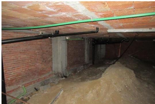
Figura 50 – Solaio di separazione verso gli ambienti seminterrati non riscaldati
