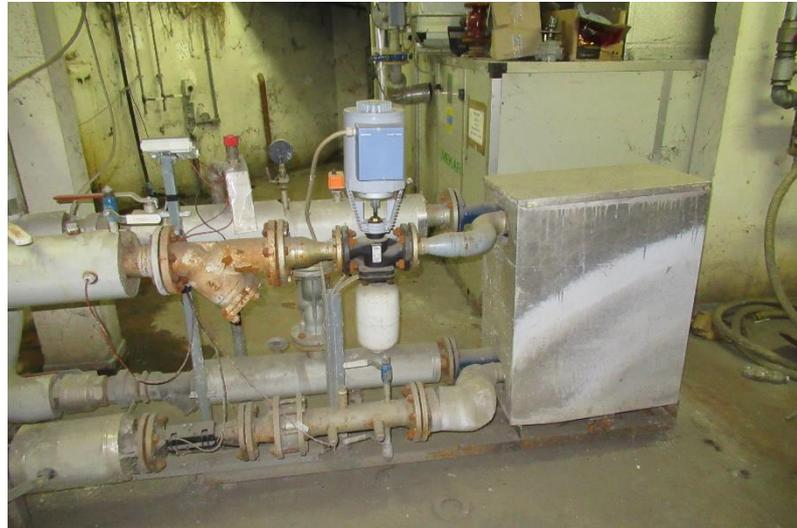
Figura 38 - Scambiatore di calore presente in centrale termica
