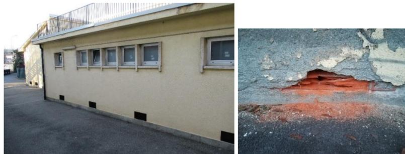
Figura 45 – Esempio tamponamenti presenti nell'edificio scolastico (immagine a sinistra), dettaglio di un tamponamento danneggiato (immagine a destra)
