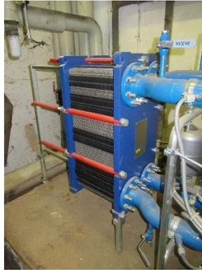
Figura 16 –Scambiatore presente in centrale termica
