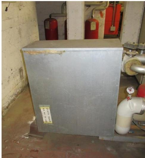
Figura 33 –Fotografia dello scambiatore presente in centrale termica
