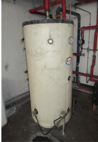
Figura 63 – Sistema di accumulo per la produzione di acs
