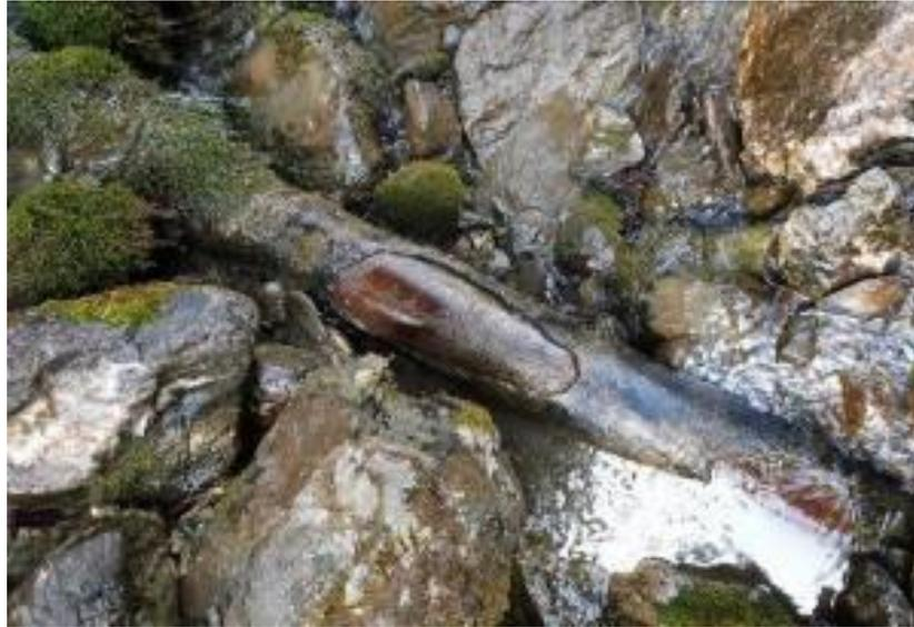
*Figura 10 - Tubazione affiorante lungo l'attraversamento di un impluvio ubicato a poche decine di metri dalla captazione.*
