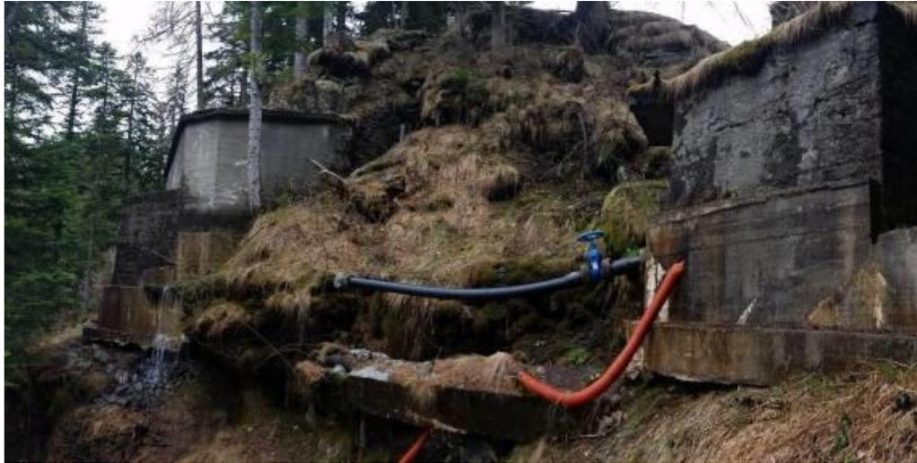
*Figura 4 - Opere di captazione dell'Orsiera, in primo piano derivazione sorgente 1, a sinistra derivazione sorgenti 2 e 3.*
