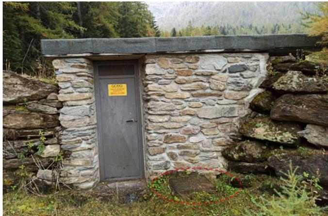
Figura 24 – Bottino di presa della sorgente Carbonella – in tratteggio rosso evidenziato il pozzetto di allaccio.
