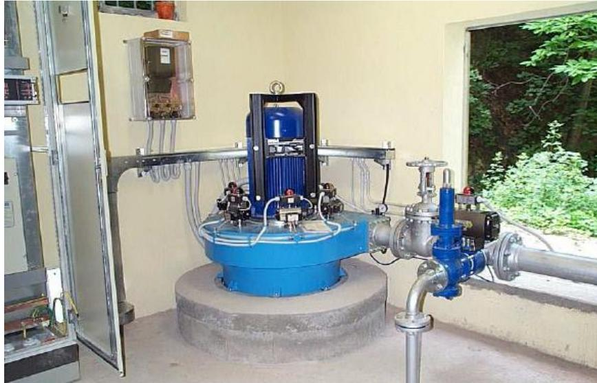
*Figura 9 - Gruppo turbina - generatore esistente.*
