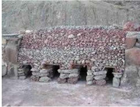
Fig. 2.1: Forno per gesso a 4 bocche in Teruel (ARAUZ D. S., 2014)
