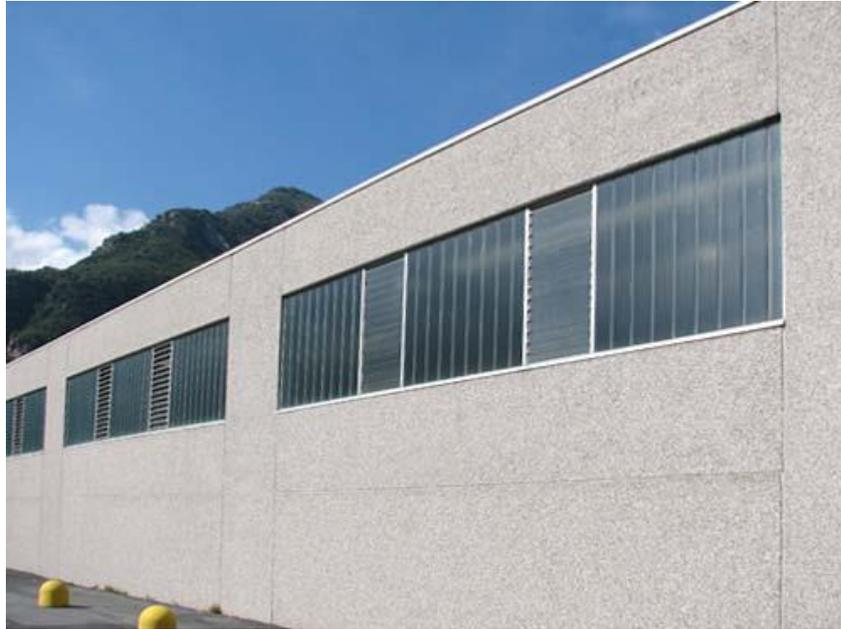
*Figura 15 - Esempio di parete perimetrale esterna prefabbricata in calcestruzzo armato con annesse vetrate*
