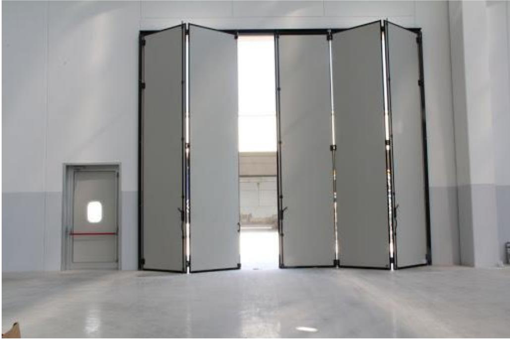
*Figura 16 - Esempio di portone a libro e di porta standard per un capannone industriale*
