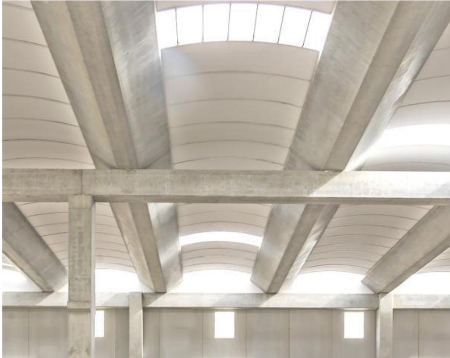
*Figura 18 - esempio di copertura a tegolo alare con lucernari*
