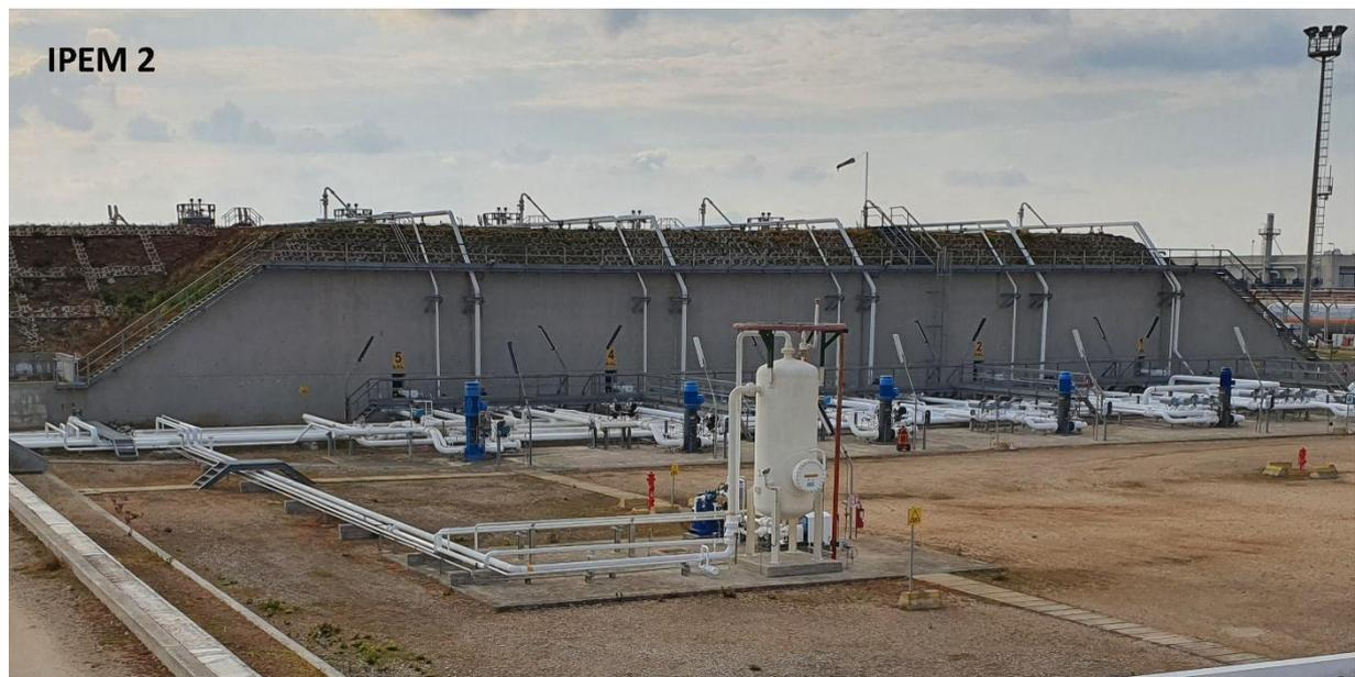
Figura 37: Foto dei serbatoi di stoccaggio interrati e della sala pompe in IPEM 2, fonte aziendale.
