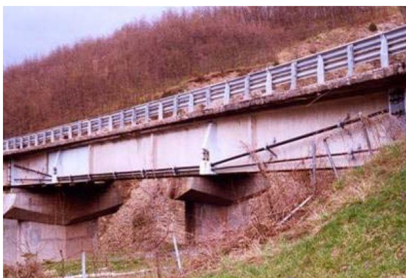
Figura 3.3 Utilizzo di cavi di precompressione esterna per il rinforzo di un ponte in c.a.p. esistente. È Possibile notare i dispositivi di deviazione e di ancoraggio. Figura tratta da [10].
