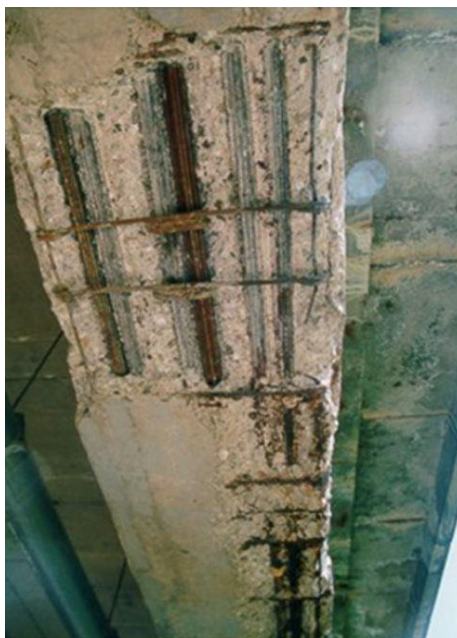
Figura 2.14 Intradosso di una trave precompressa con armatura di precompressione fortemente danneggiata. Si nota la distribuzione casuale dei fenomeni corrosivi, nella stessa sezione coesistono cavi completamente corrosi e cavi integri. Lo stesso cavo lungo il proprio sviluppo presenta forti eterogeneità nella percentuale di area resistente persa. La figura è tratta da [10].
