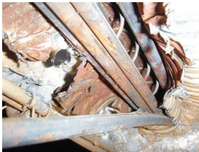
Figura 2.13 Cavi di precompressione all'interno di una guaina completamente non iniettata. La figura è tratta da [10].
