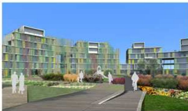
vista sul prospetto a sud dal parco interno
