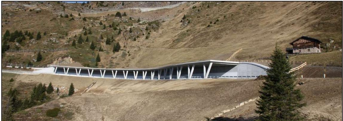
Figura 9.2: Esempio di galleria paravalanghe già realizzata. (Fonte: La Voce di Bolzano)
