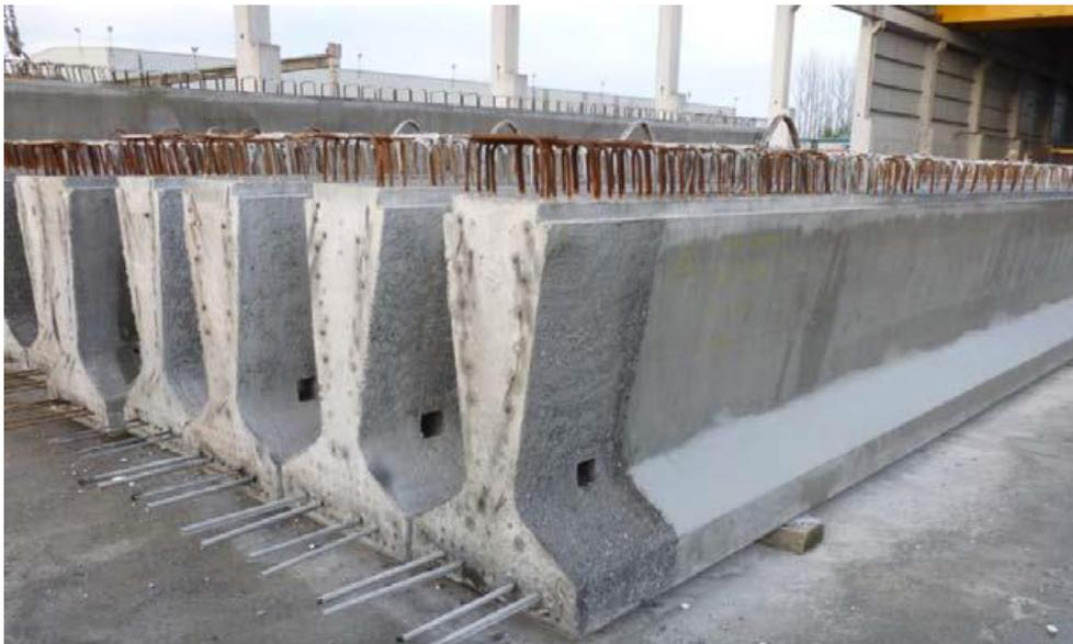
*Figura 17 - Fori per alloggiamento armature da precompressione per collegamento con travi trasversali*
