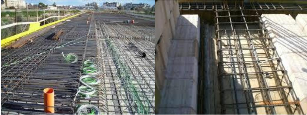
*Figura 8 - Installazione sensori in fibra ottica su una nuova costruzione*
