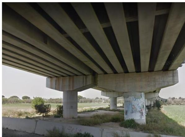
*Figura 16 – Impalcato con travi prefabbricate precomprese*
