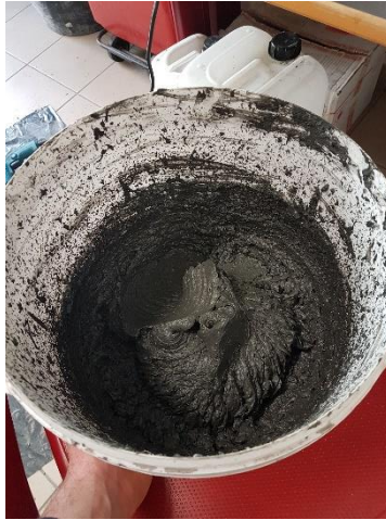
Fig. 2.28: miscelazione completa della pasta cementizia con la schiuma.
