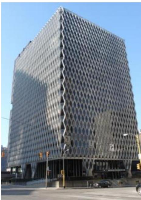
*Figura 18 - Struttura esoscheletrica con diagrid (IBM Building, Pittsburgh).*
