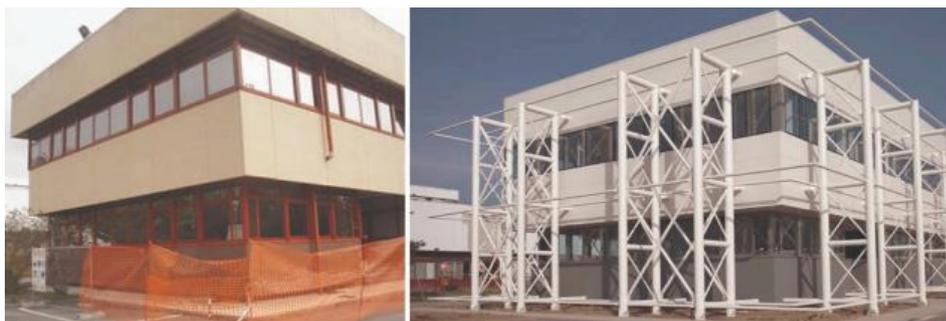
*Figura 12 - Palazzina Uffici pre e post intervento di adeguamento sismico.*
