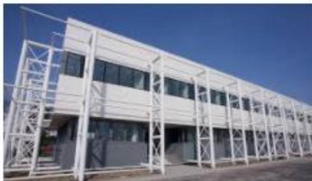
*Figura 17 - Edificio della società Magneti Marelli S.p.a. in seguito ad intervento di adeguamento sismico.*
