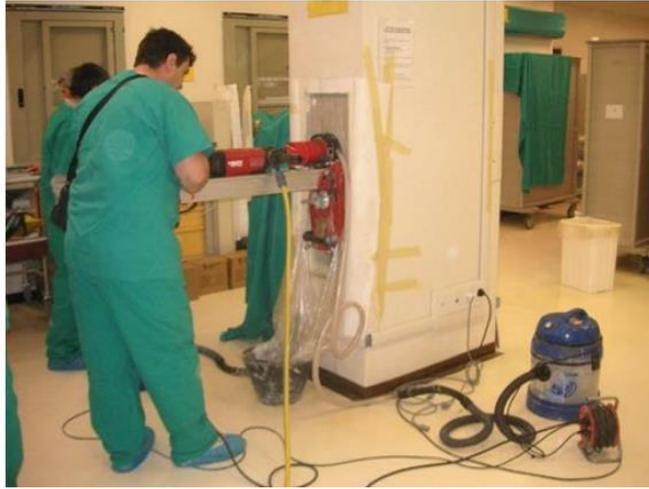
*Figura 41 - Prelievo della carota in calcestruzzo [Valutazione della vulnerabilità sismica, Ing. Centioni, 2010].*
