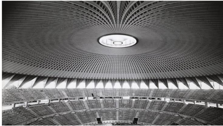
*Figura 5: Copertura del Palazzetto dello Sport di Roma realizzato da Nervi in occasione delle Olimpiadi*
