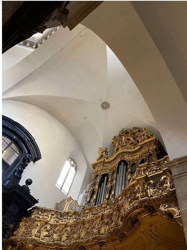
*Figura 2.10 – Fotografia della volta a crociera sul braccio del transetto*
