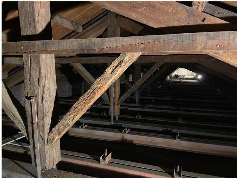
*Figura 3.8 - Fotografia del sottotetto della navata centrale – Capriate, travi trasversali e tiranti*
