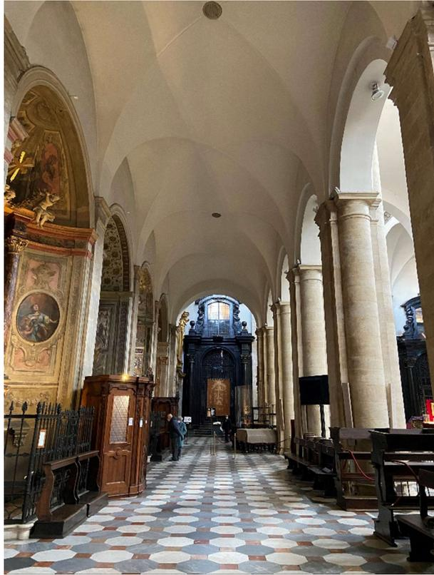
*Figura 2.8 – Fotografia delle volte a crociera sulle navate laterali*
