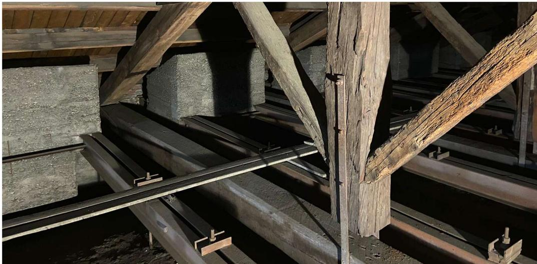
*Figura 3.9 - Fotografia del sottotetto della navata centrale - Capriate, travi trasversali, tiranti e blocchi in calcestruzzo*
