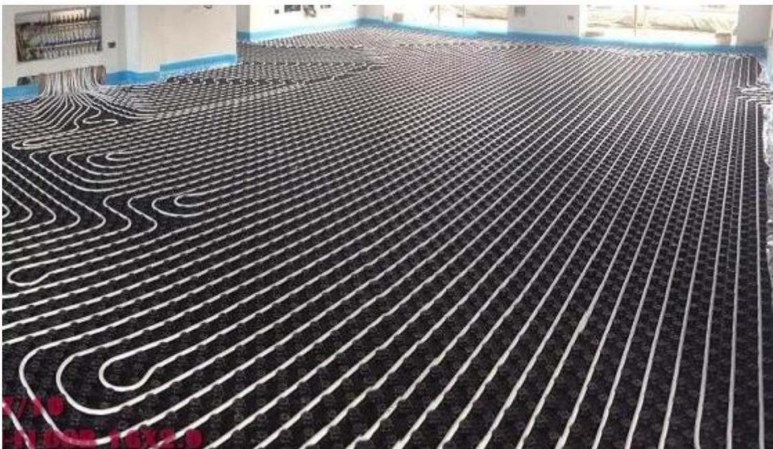
**Figura 3.1:** Esempio pavimenti radianti [6]
