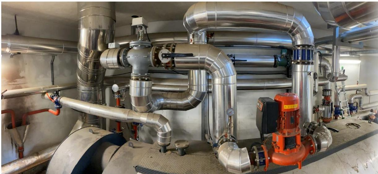
*Figura 30: Valvola a tre vie della caldaia d'acqua.*
