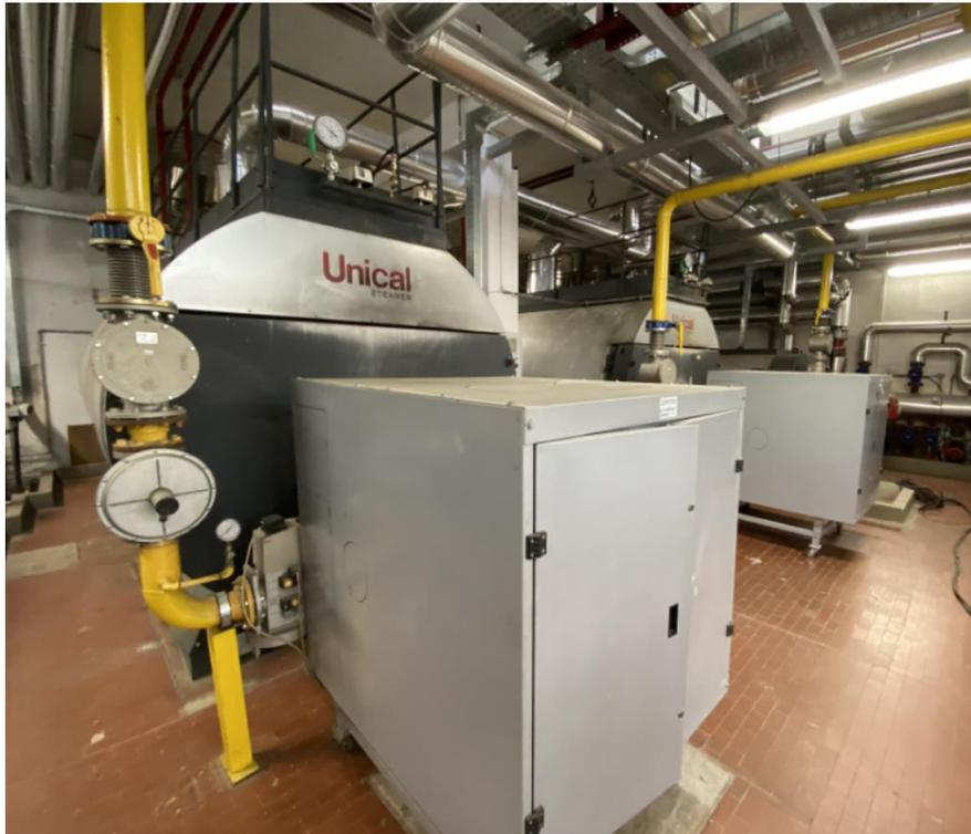
*Figura 26: Generatori di vapore della centrale termica dell'Ospedale.*
