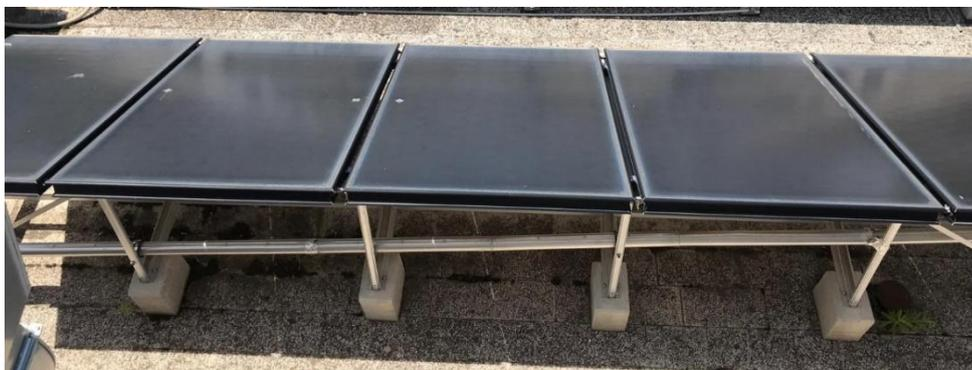
*Figura 32 – Dettaglio collettori solari termici*
