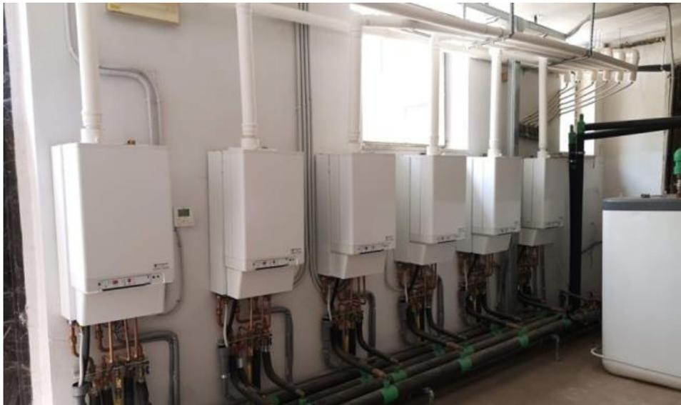
*Figura 31 – Particolare delle n.6 caldaie a condensazione*
