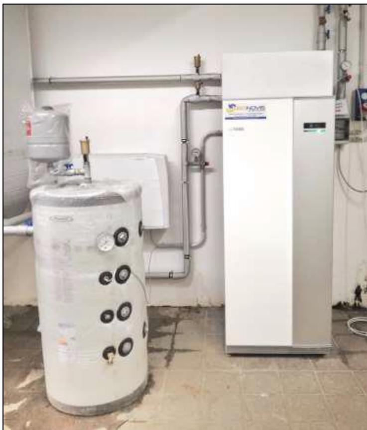
*Figura 23: Pompa di calore (a destra), ventilconvettore (dietro), vaso di accumulo (a sinistra).*
