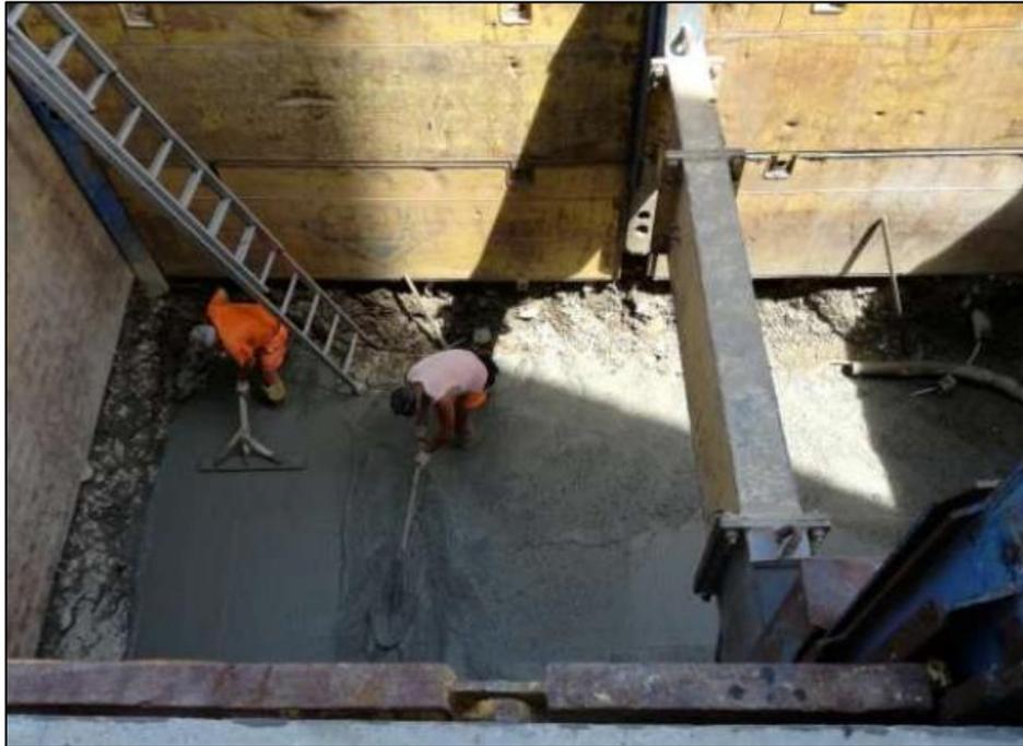
*Figura 19: Fasi costruttive, livellazione.*
