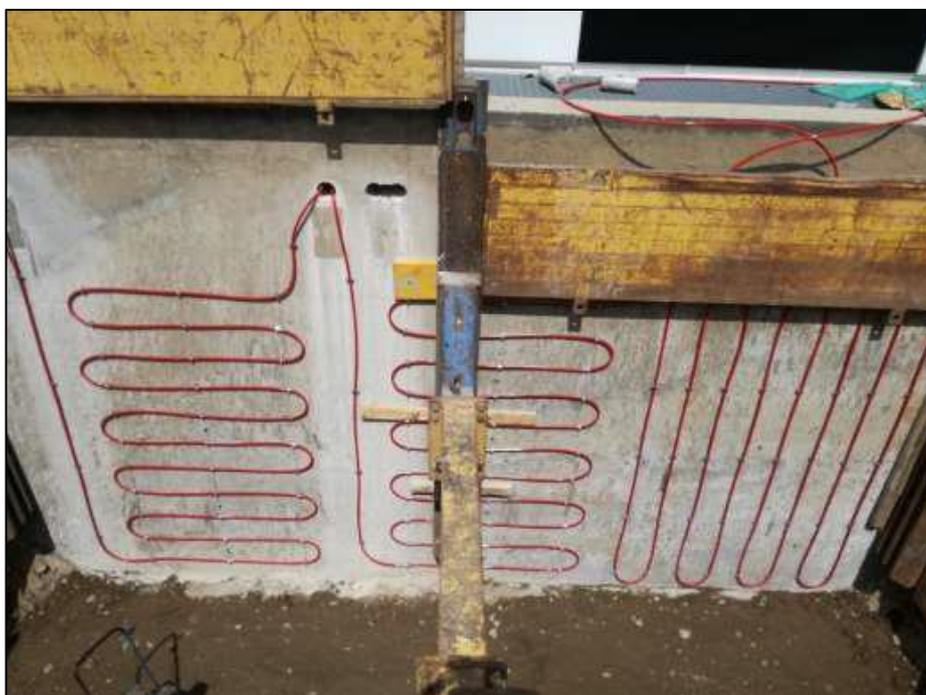
Figura 20: Sistemazione finale delle serpentine.
