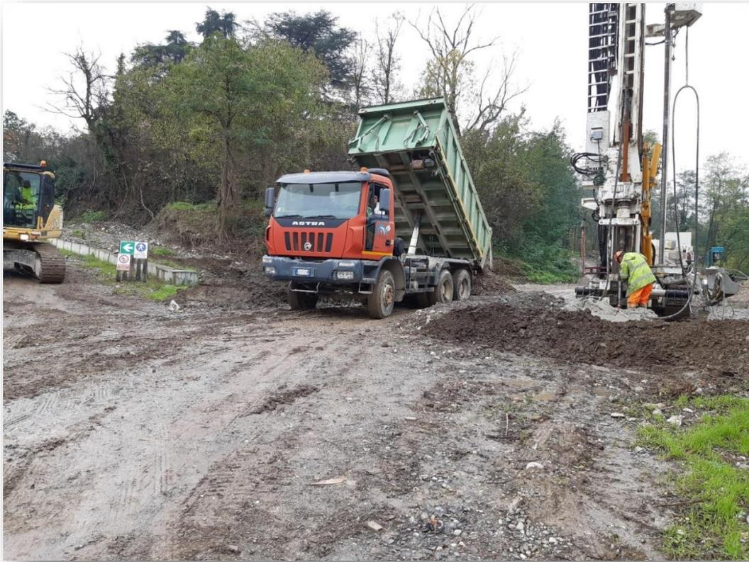
Figura 9: contenimento della miscela cementizia fuoriuscente, tramite arginatura con sponde in terra
