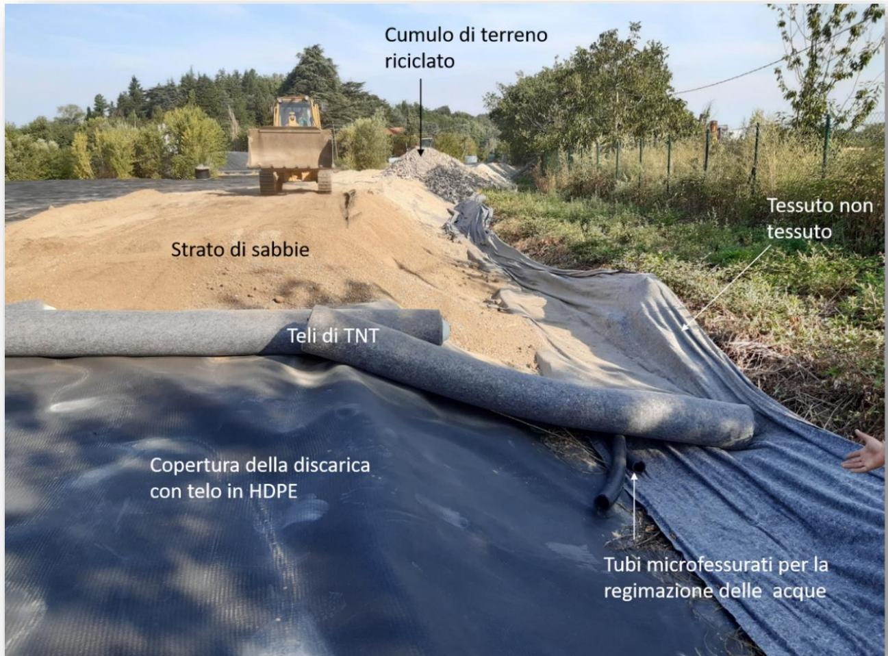
*Figura 30: elementi utilizzati per la realizzazione della pista*
