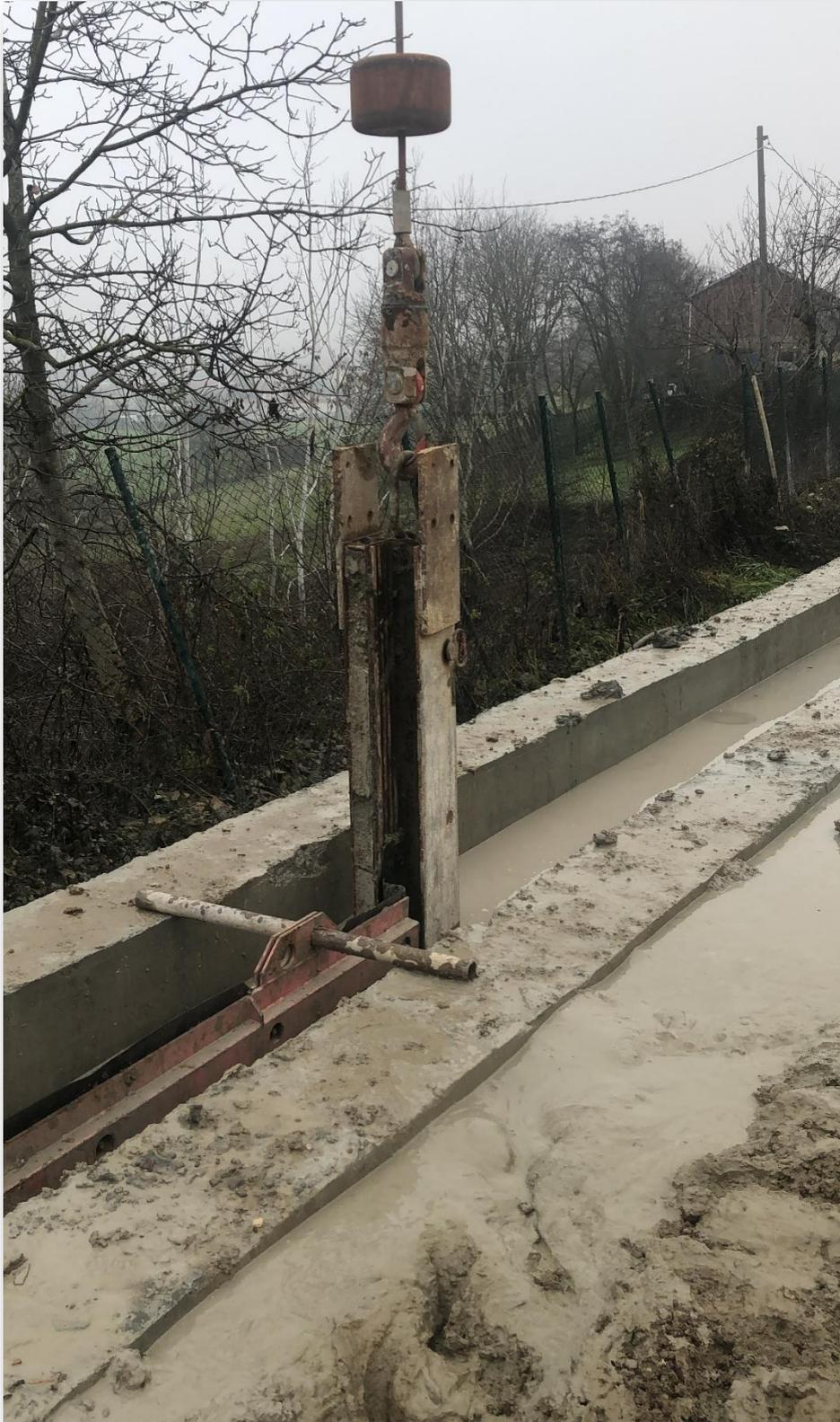
*Figura 17: limitazione della fuoriuscita del fango bentonitico durante la fase di scavo del setto e del calo della geomembrana grazie ai cordoli guida*
