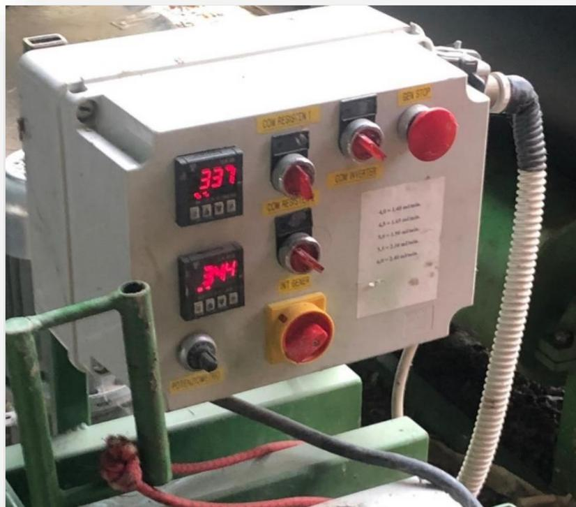
Figura 46: quadro dei comandi per la regolazione dei parametri in fase di saldatura
