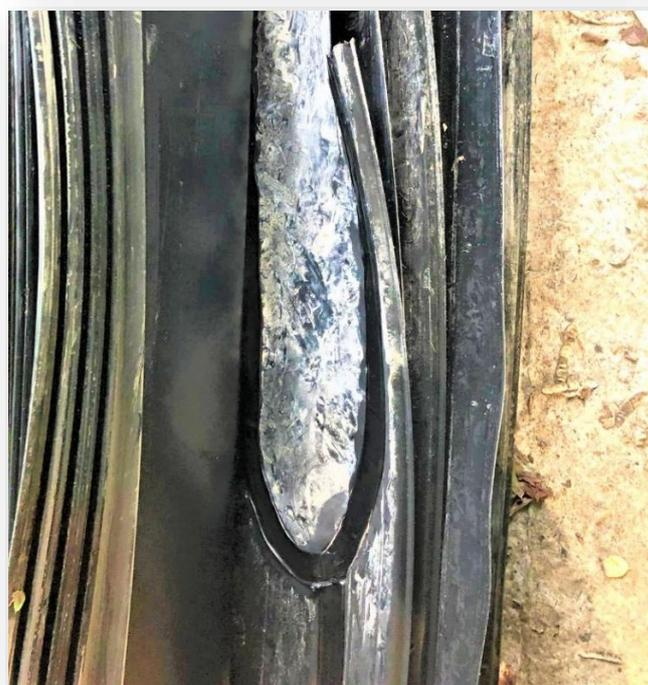
*Figura 55: correzione apportata al telo, dopo essere stato sottoposto a saldatura a doppia pista*
