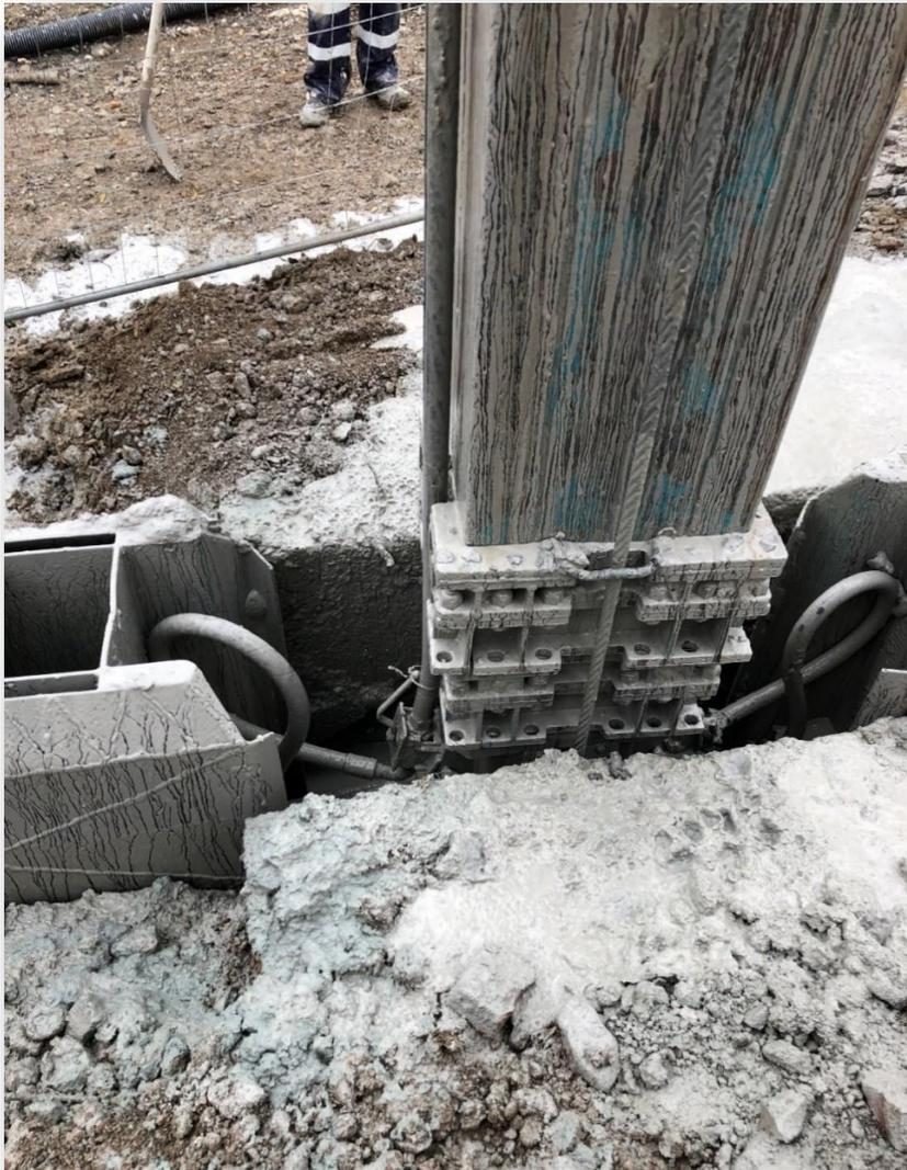
*Figura 14: scavo del setto con la benna*
