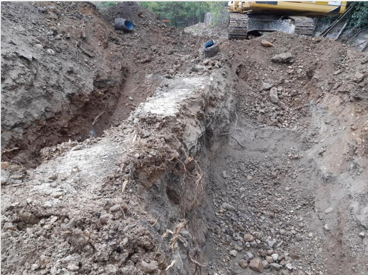
*Figura 8: scavo superficiale in campo prove per portare alla luce i primi metri delle colonne in jet-grouting e valutare le dimensioni ottenute con le diverse pressioni di iniezione*
