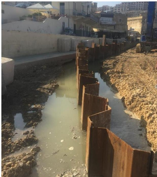
Figura 4.6 - Esempio di palancole metalliche infisse. [55]
