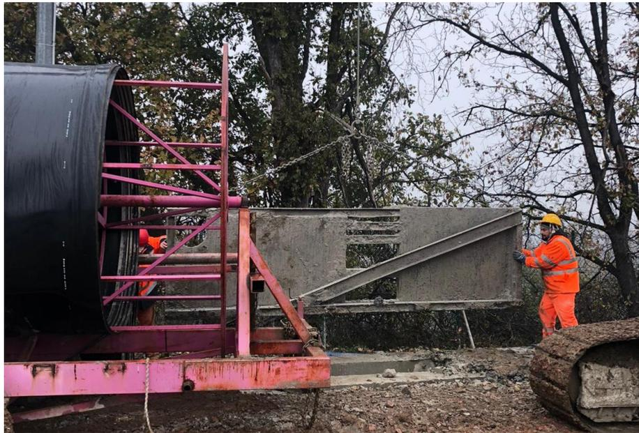
*Figura 6.34 - Inserimento della zavorra in ferro nel telo in HDPE mediante il supporto della gru.*
