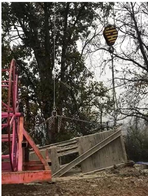
*Figura 6.36 - Fase di rimozione della zavorra in ferro per mezzo del sollevamento della stessa da una sua estremità.*
