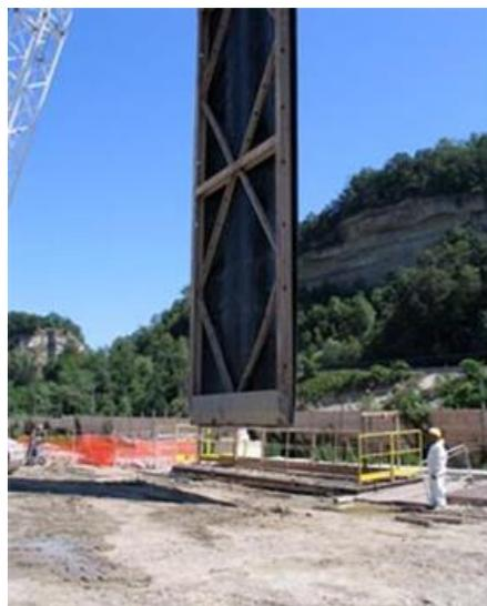
*Figura 4.11 - Calaggio del telo mediante telaio metallico. [1]*
