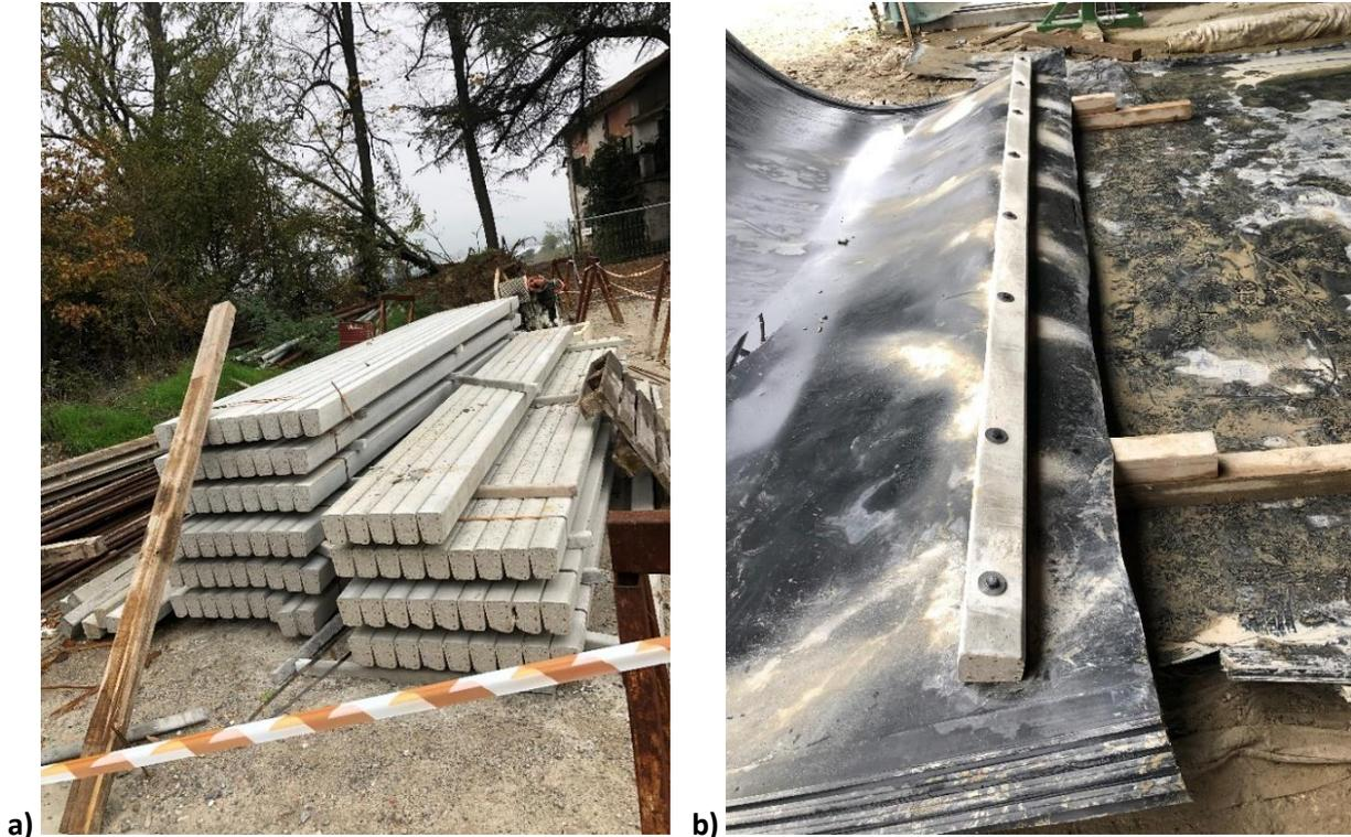
Figura 6.29 - Zavorre in calcestruzzo: a) poste nel cantiere; b) montate sul telo in HDPE.
