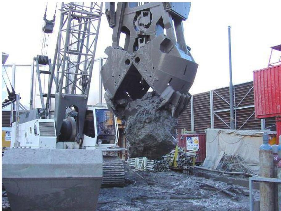
*Figura 4.8 - Rimozione di trovanti mediante benna mordente. [6]*
