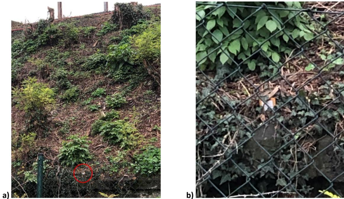
Figura 7.3 - a) Porzione del rilevato ferroviario localizzato nella zona a Sud-Est del cantiere, con evidenziato mediante un cerchio rosso il prisma; b) Ingrandimento della mira catarinfrangente.
