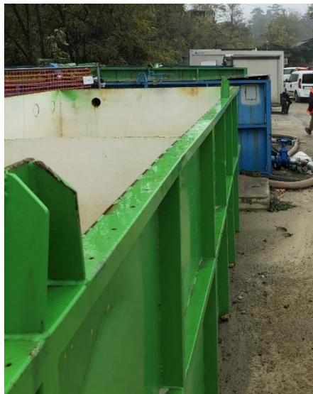
Figura 3.4 - Vasche di decantazione delle acque reflue.
