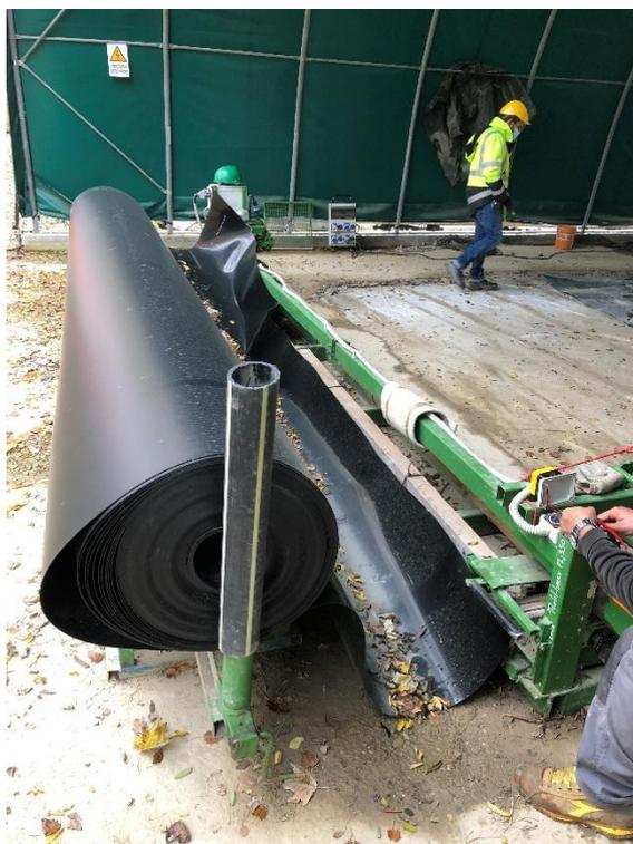
Figura 6.7 - Telo in HDPE pronto per l'operazione di saldatura dei giunti.
