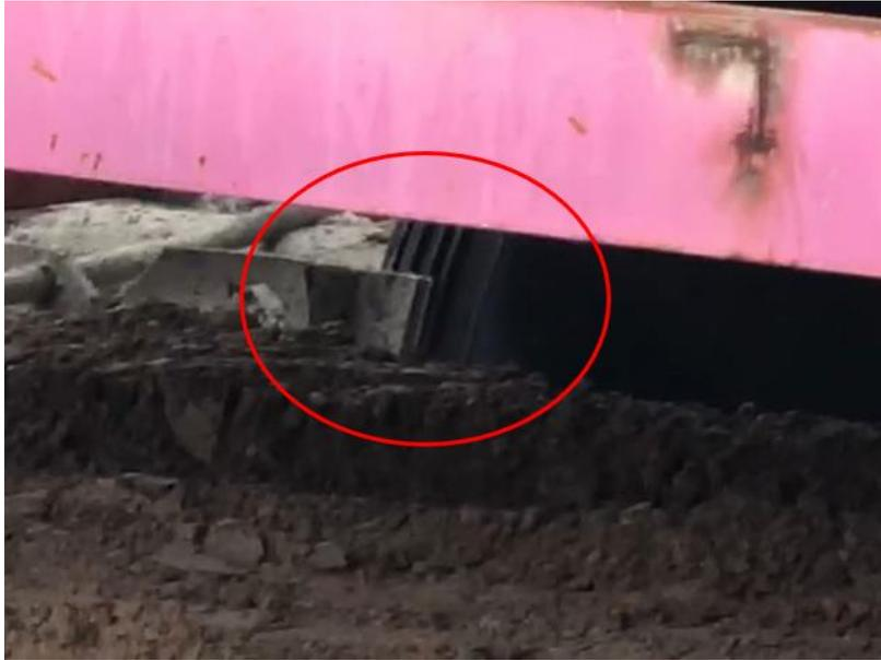
*Figura 6.32 - Accoppiamento tra il giunto del telo posto sulla bobina e quello appartenente al pannello precedentemente realizzato evidenziato in rosso.*
