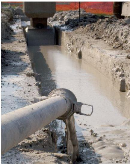
*Figura 6.6 - Getto della miscela costituita da Solidur® e acqua. [s8]*
