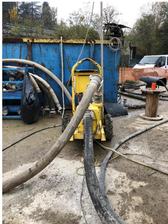
*Figura 6.13 - Pompa mediante il quale la miscela raggiunge la zona di esecuzione del diaframma.*
