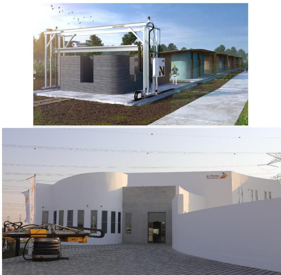
Figura 75: In alto, ricostruzione di un possibile processo di stampa delle case [40]. In basso, il più grande edificio al mondo stampato in 3D (Dubai), in basso a sinistra è presente anche il macchinario utilizzato [41]
