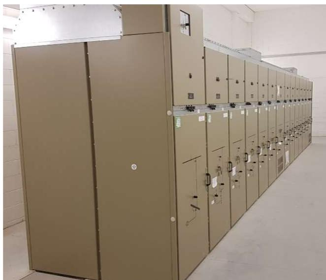
**Figura 1.9:** Interruttori di protezione linee MT in CP
