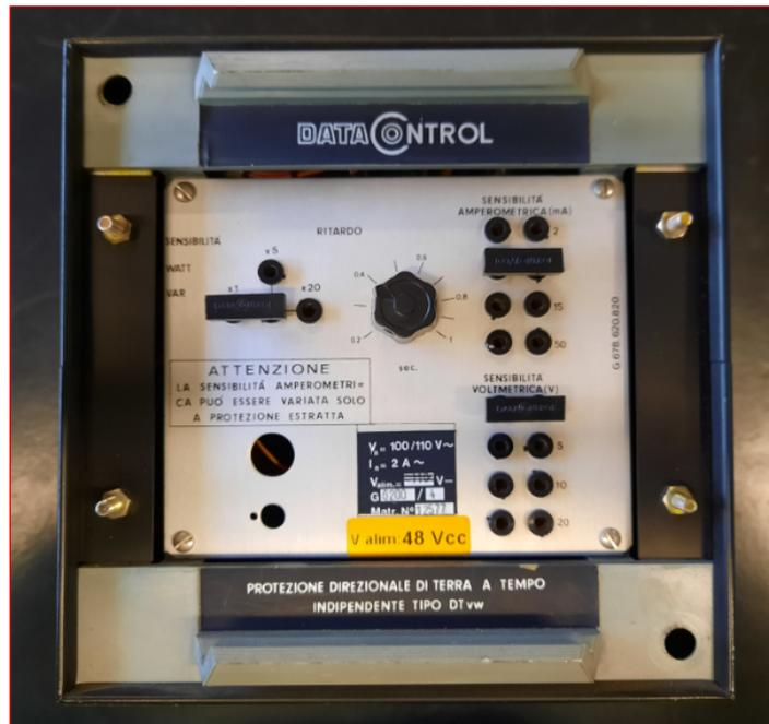
**Figura 4.2: Relè elettromeccanico Data Control**
