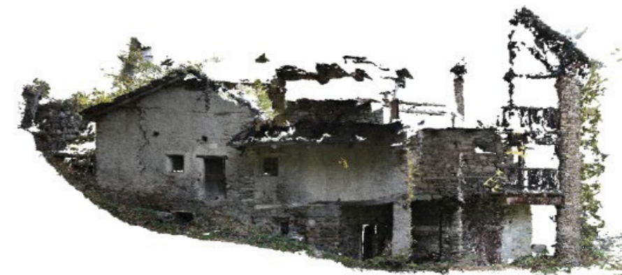
Figura 5.35 Nuvola fotogrammetrica della Casa delle Colonne generata dalle immagini acquisite con Canon 1200d in Metashape. Vista dal prospetto sud.
