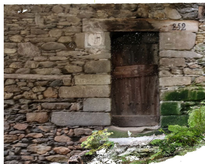
Figure 5.33 e 5.34 Comparazione delle dense cloud fotogrammetriche da Canon 1200d (sinistra) e da smarphone Samsung s10e (destra) di una porzione del prospetto nord della Casa delle Colonne.
