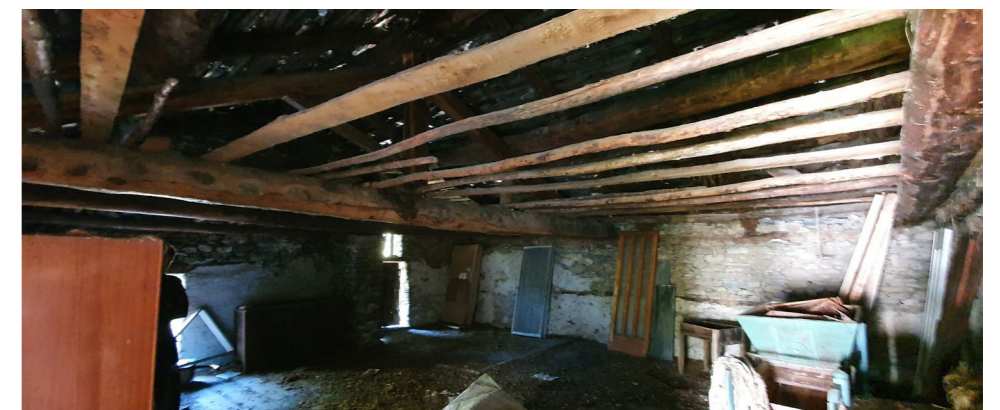
Figura 6.10 Fienile del corpo nuovo del Complesso Garnero , con la struttura del tetto a capriata soprastante. Foto acquisita il 3/10/2020
