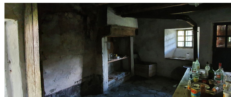
Figura 6.24 Camino nel corpo nuovo del Complesso Garnero . Foto acquisita il 3/10/2020
