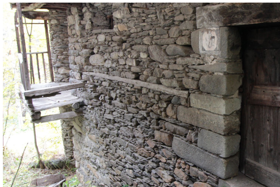
Figura 6.43 Trave lignea inserita nella muratura in pietra con funzione di assestamento. Foto acquisita il 21/10/2020
