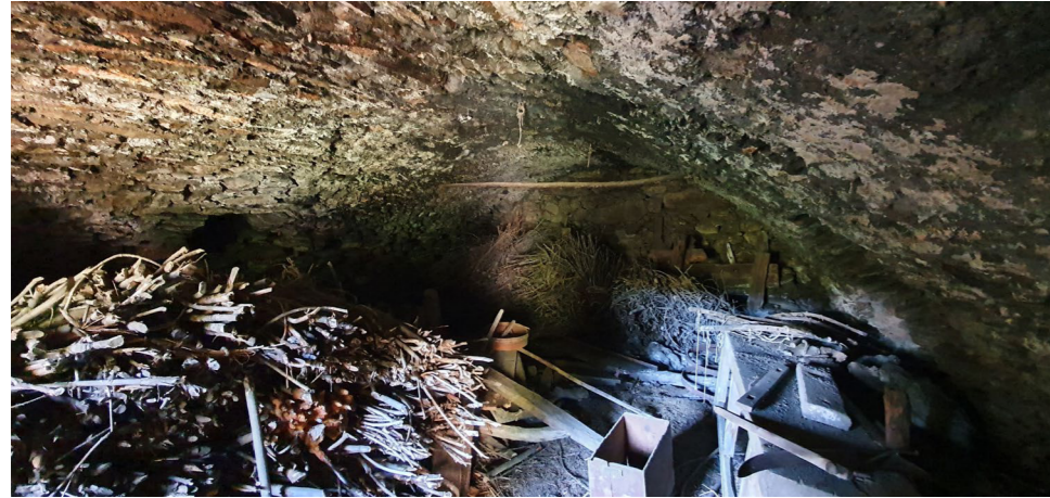
Figura 6.7 Stalla del corpo nord della Casa delle Colonne , ora adibita a deposito di materiali vari. Si nota la struttura voltata (a botte) del soffitto. Foto acquisita il 3/10/2020
