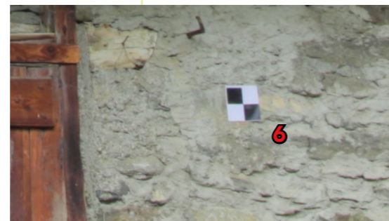
(Sopra) Figura 5.7 Disposizione dei GCP oggetto del rilievo celerimetrico sui prospetti degli edifici in esame. Dense cloud fotogrammetrica terrestre elaborata in software Metashape
