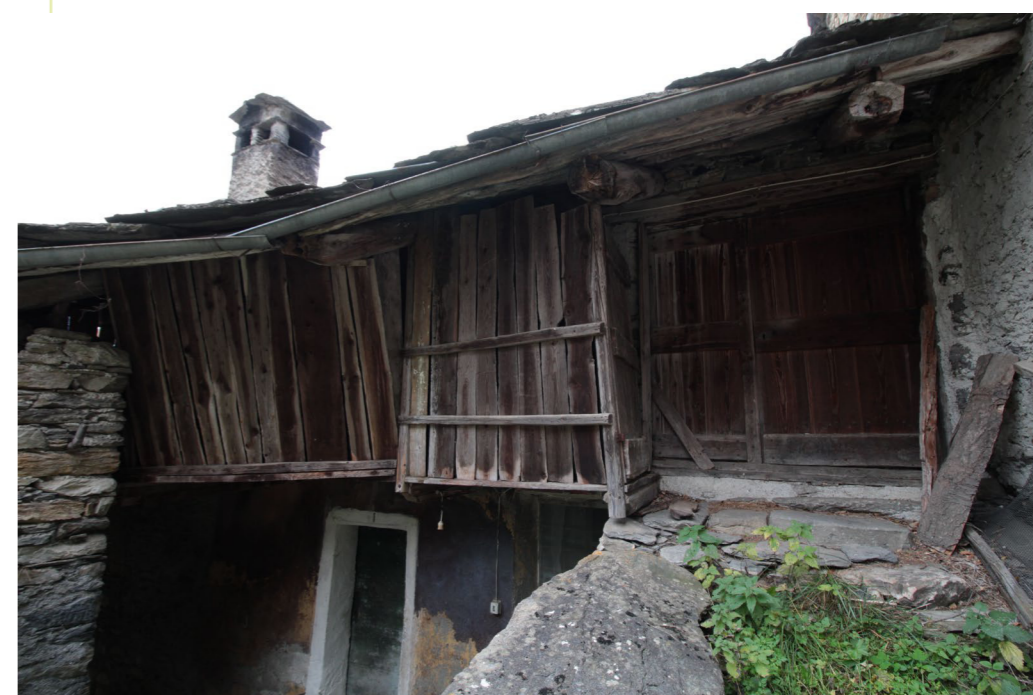
Figura 6.45 Deposito esterno per il fieno in prossimità dell'ingresso del fienile del corpo a valle del Complesso Garnero .
