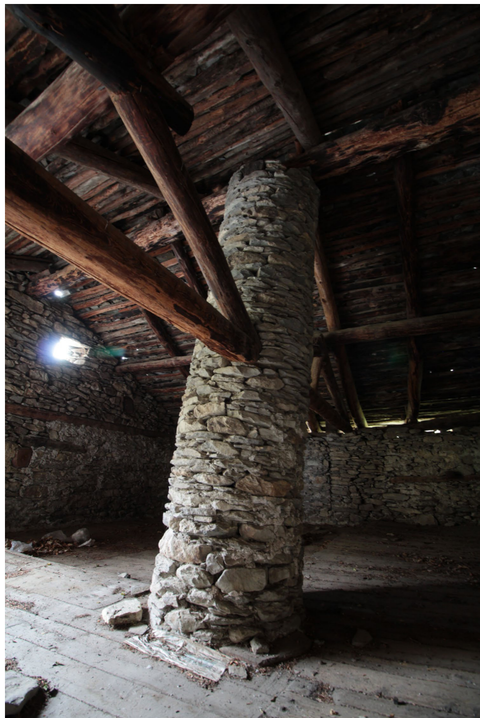
Figura 6.38 "Colonna rotonda" di supporto al tetto nel fienile del corpo a monte del Complesso Garnero . Foto acquisita il 21/10/2020.
