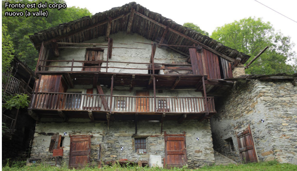
Fronte nord del corpo antico (a monte)
