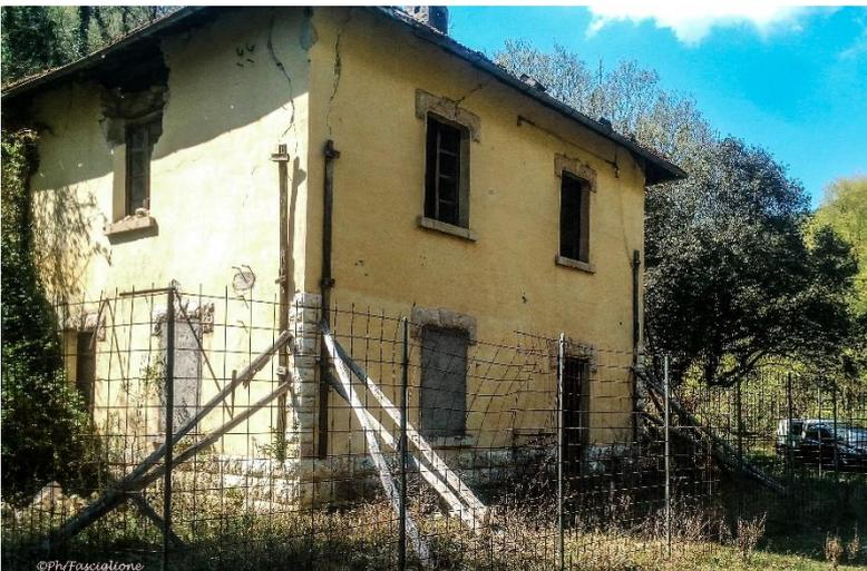
angolari all'altezza dell'appoggio della copertura, che in questo caso, a differenza di quello di Norcia, ha risposto in modo elastico al sisma, senza causare il crollo dell'intera struttura.
