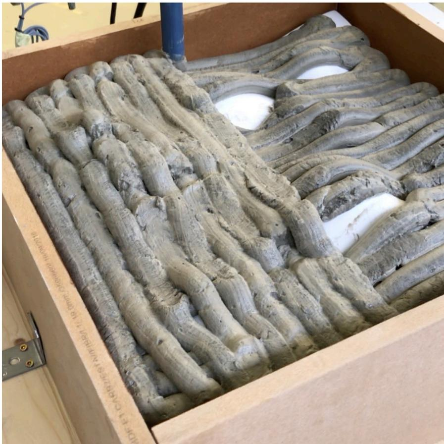
*Figura 117 – Ripresa fotografica eseguita durante la realizzazione del secondo ed ultimo strato del pannello estruso in cassaforma removibile. Si evidenzia la rotazione di 90 gradi del percorso di stampa seguito per questo strato rispetto a quello sottostante.*
