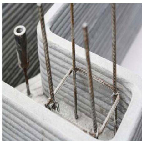
Figura 18 – Esempio di integrazione delle classiche armature in acciaio in un elemento stampato con funzione di cassaforma permanente [4].
