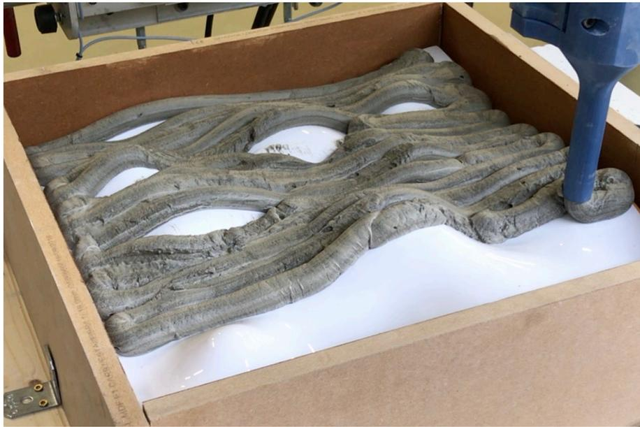
*Figura 116 – Ripresa fotografica eseguita durante la realizzazione del primo strato del pannello estruso in cassaforma removibile. Si evidenziano le discontinuità causate dallo scivolamento del filamento sulla superficie di base della cassaforma in corrispondenza delle zone a maggiore ripidità.*
