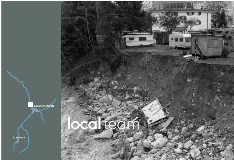
fig 44. Esondazione del torrente Vermenagna alle porte di Limone, grave erosione dell'argine
