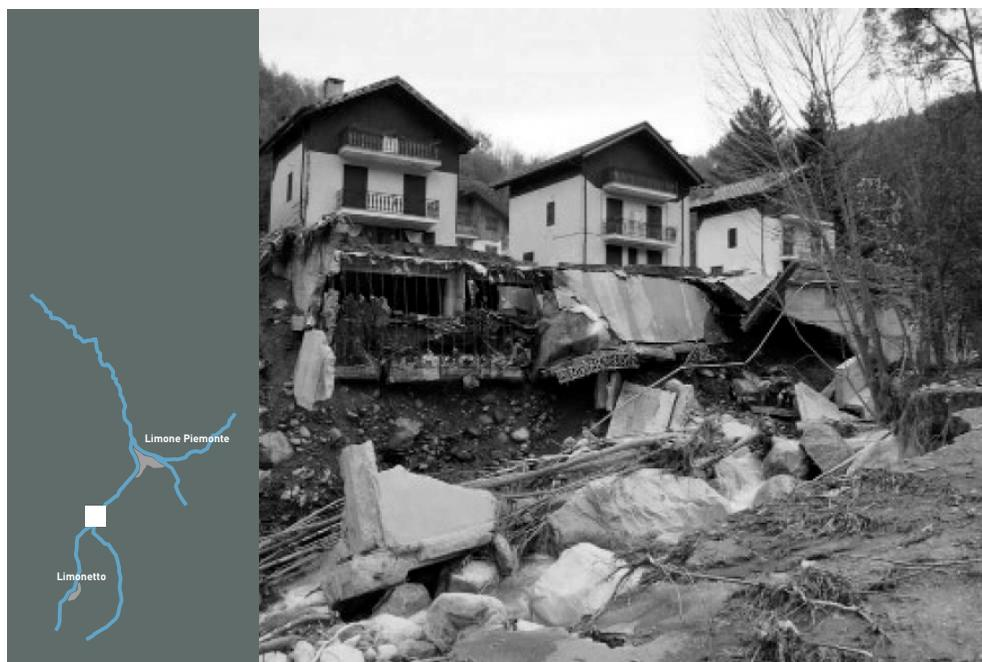
fig 35. Erosione spondale del Torrente Vermenagna che ha invaso anche la sede stradale presso il Villaggio Miramonti , arrecando danni agli edifici e all'infrastruttura stradale
