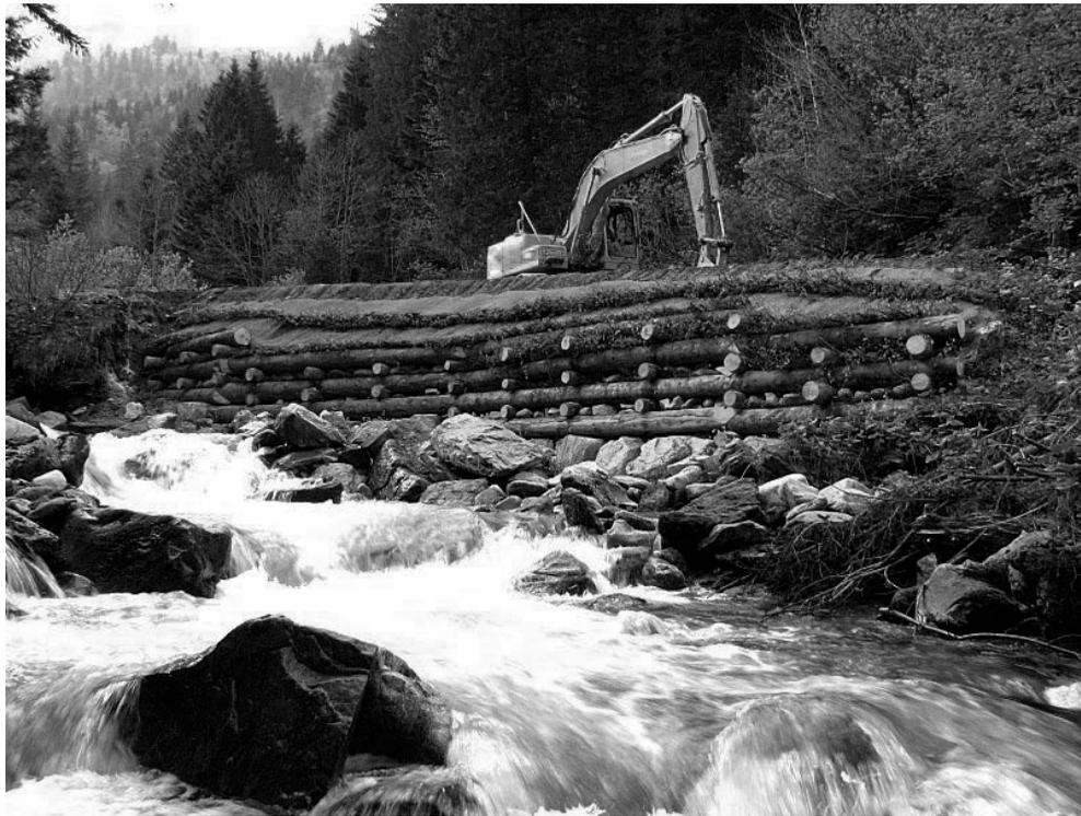
fig 21. L'ingegneria naturalistica nel mantenimento spondale.
