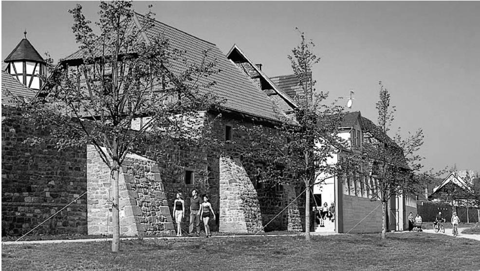
fig 30. Le mura storiche della città diventate elementi di protezione dalle piene del Meno
