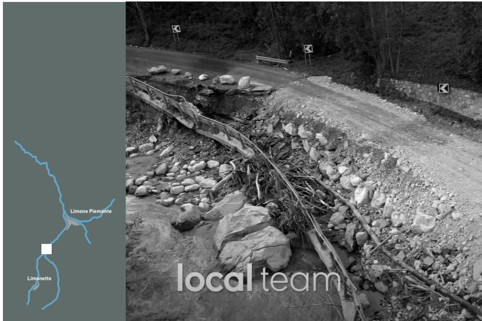
fig 36. Erosione spondale del Torrente Vermenagna che ha invaso anche la sede stradale presso il Villaggio Miramonti , arrecando danni agli edifici e all'infrastruttura stradale
