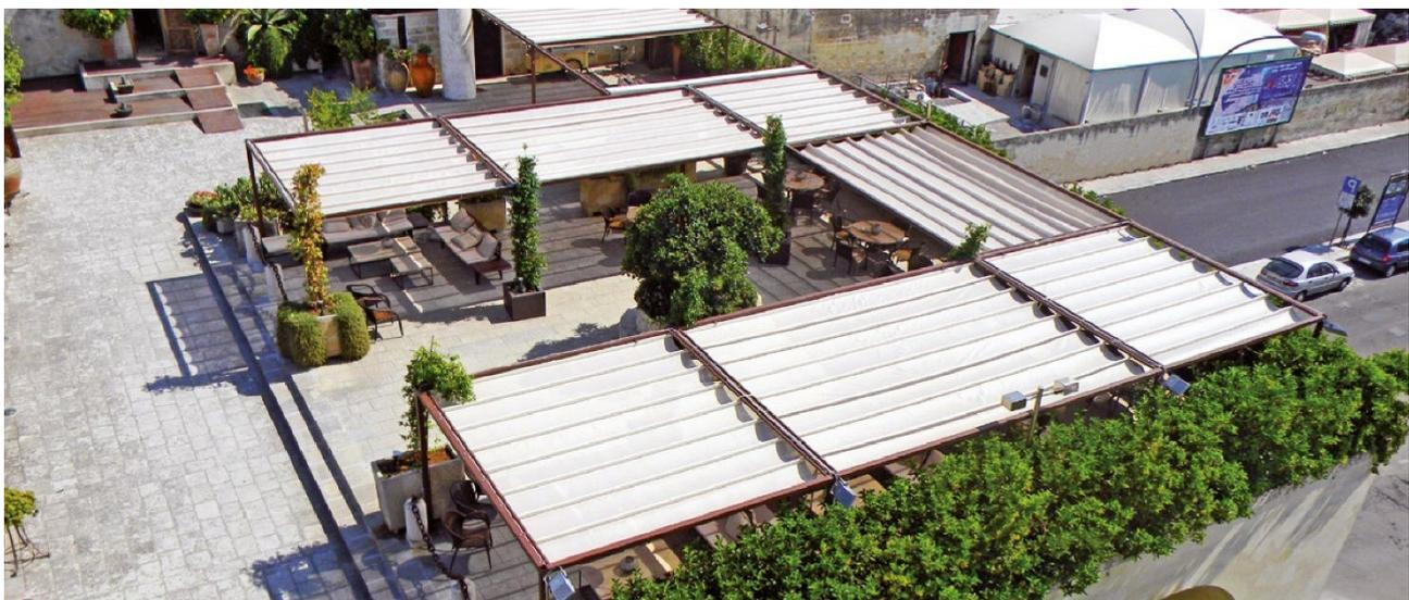
**Beach System:** Sistema di copertura e sintonimento manuale con telaio in alluminio e telo in PVC ignifugo
