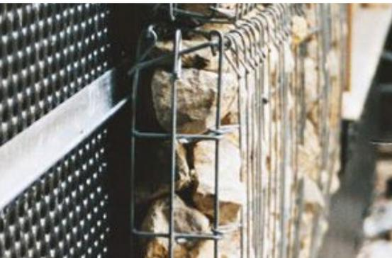
per la costruzione di un edificio. L'intero rivestimento è costituito da gabbie agganciate alla struttura principale, le quali agiscono come uno stato di percolazione alternativo alle gronde e ai sistemi di scolo delle acque. Le gabbie sono state riempite a mano con pietre locali, per un totale di venti tonnellate di massa termica in grado di regolare il trasferimento del calore, caratterizzando gli interni con una condizione di comfort e un fabbisogno energetico minimo.
