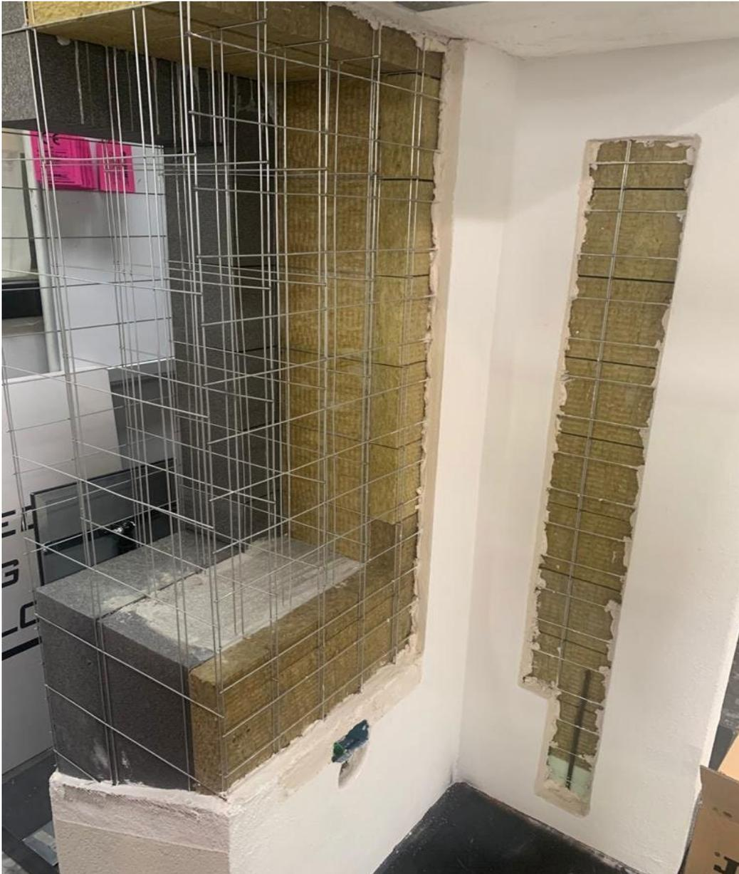
Figura 38: Particolare spalletta parete Ecosism dove si vuole fare il focus sulla maglia 3D metallica che avvolge il cassero in EPS, dove nell'anima alloggerà il setto in cls, 2020, Foto realizzata da noi durante il sopralluogo in azienda.
