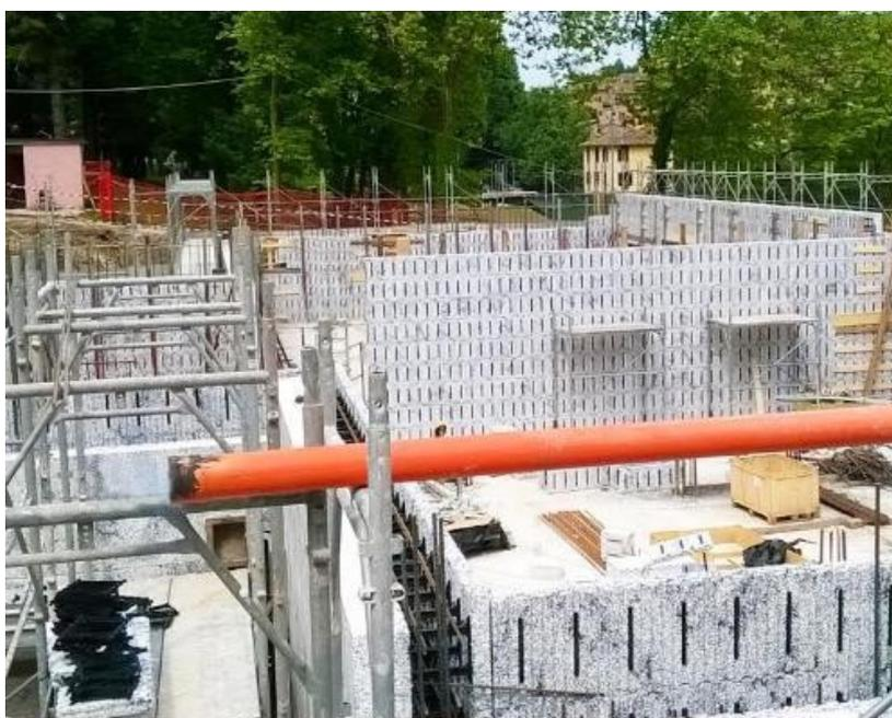
Fig. 28: Foto di cantiere con vista posa casseri per realizzazione pareti interpiano.
