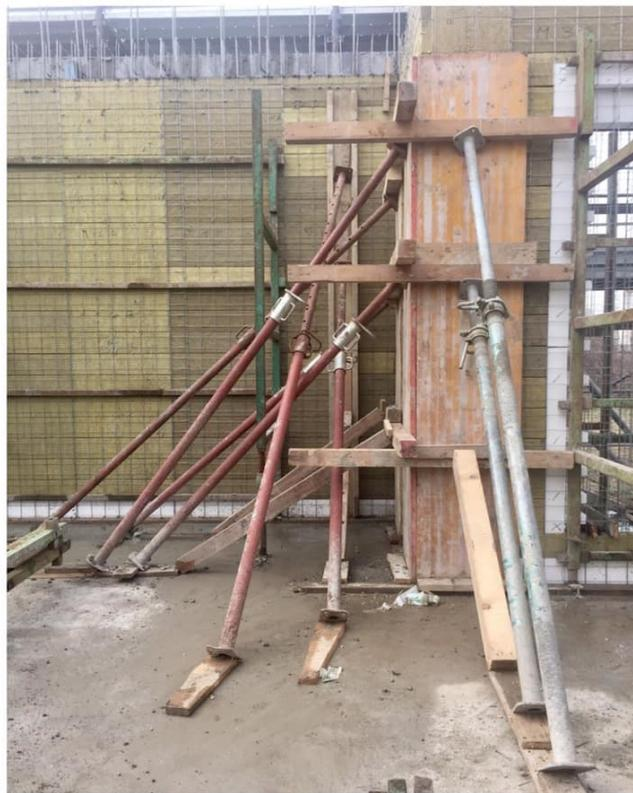
Figura 72: Correzione tenuta tramite rinforzo. Materiale fornito da “Officina23”.
