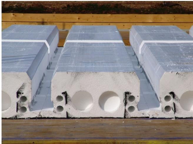
Figura 5: Tipologia dell'orditura delle pignatte in EPS, per la realizzazione del solaio alleggerito. Come si evince, in questo caso non risulta necessario il travetto reggi- pignatta, grazie proprio al peso specifico ridotto del materiale. Nel suddetto caso sarà necessaria solo l'armatura delle travi, e tondini di ancoraggio longitudinali e trasversali per la collaborazione del solaio. 2012 Pastbau Comptex.
