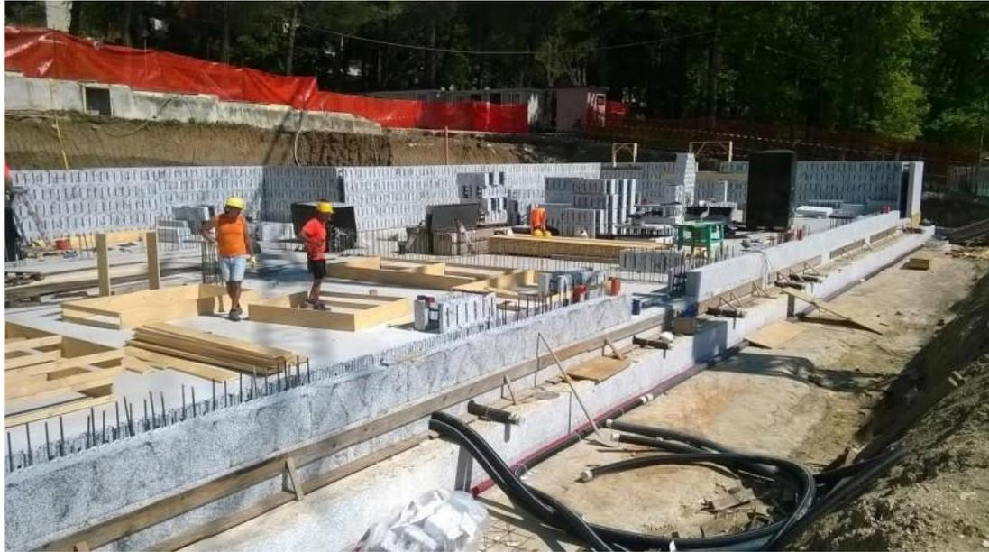
Fig. 29 Vista di cantiere posa dei primi casseri sul primo solaio. Fonte: Climablock
