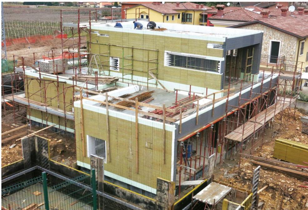
Fig. 11: Fase di cantiere durante l'esecuzione dei lavori. Facilmente riconoscibile il sistema a ICF come soluzione costruttiva tecnologica. Fonte: Pontarolo Engineering
