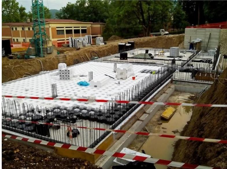
Fig. 31 Posa del solaio aerato sui casseri a perdere. Fonte: Climabolck
