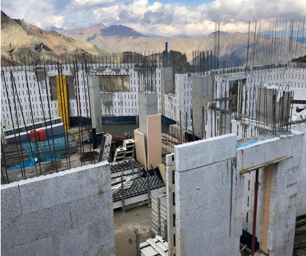
Fig. 35 Vista di cantiere durante la posa dei casseri per la realizzazione delle pareti.
