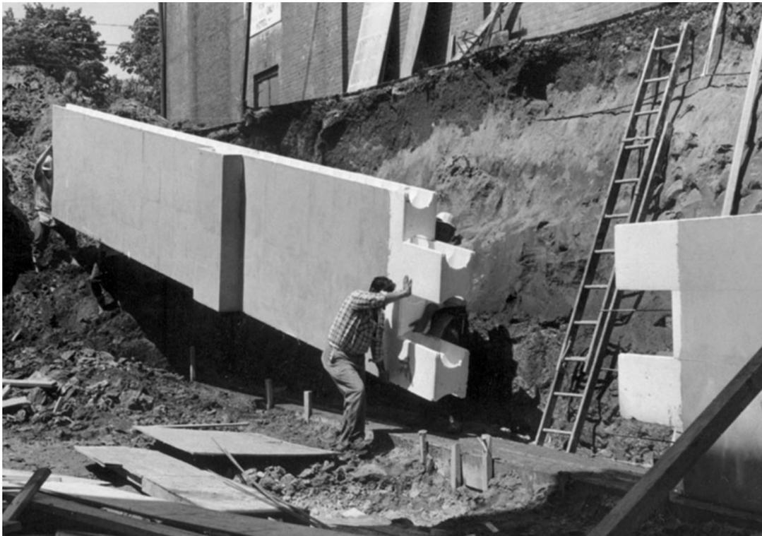
Fig4: Posa di un pannello per una parete contro-terra in un cantiere negli USA. 1970 History of IC-RBS
