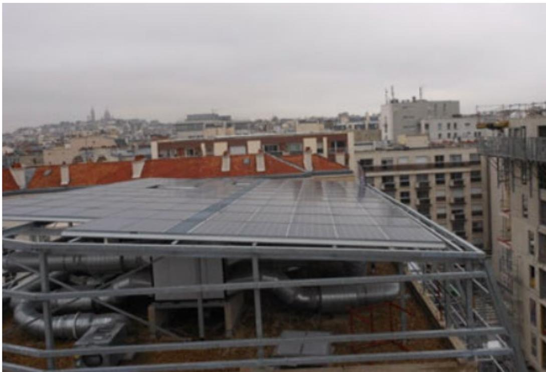
Fig. 27 Tetto fotovoltaico, con unità di trattamento aria a doppio flusso visibile sotto i pannelli fotovoltaici: ICF Sablier locatment
