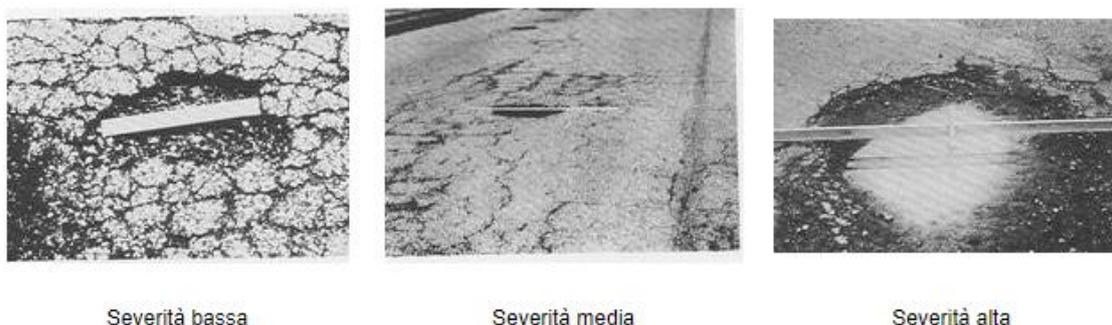
Figura 1.9 Gradi di severità delle buche
