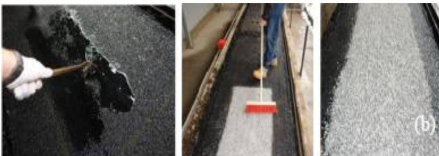
*Figura 6.11 Esempio di applicazione di  $TiO_2$  tramite processo di diffusione*
