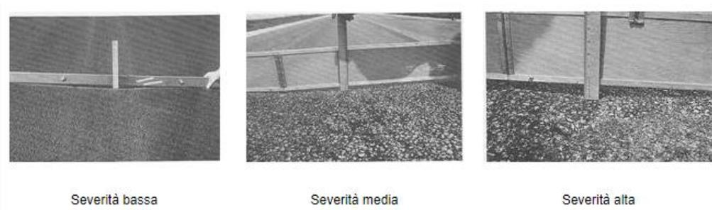
Figura 1.5 Gradi di severità dell'ormaiamento
