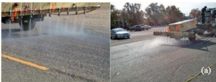
*Figura 6.10 Esempio di applicazione di  $TiO_2$  tramite rivestimento a spruzzo*
