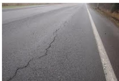
Figura 1.4 Esempio di fessurazione longitudinale
