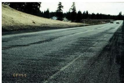
Figura 1.8 Esempio di scagliatura superficiale
