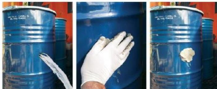
Figura 3.5 Applicazione di mastice sigillante sul foro
