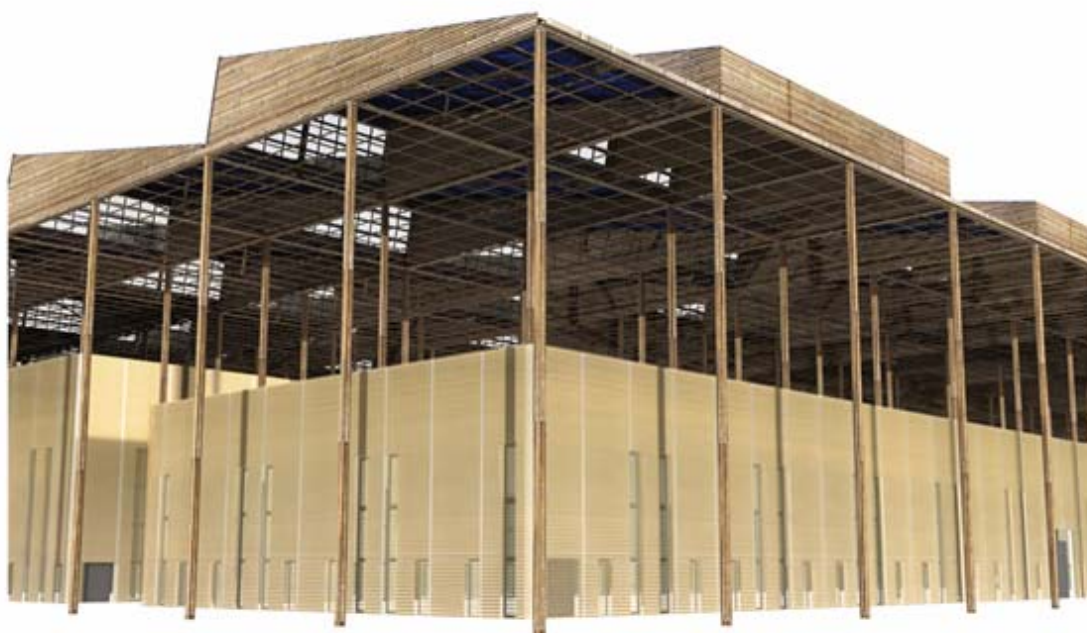
Struttura portante della copertura in bambù
