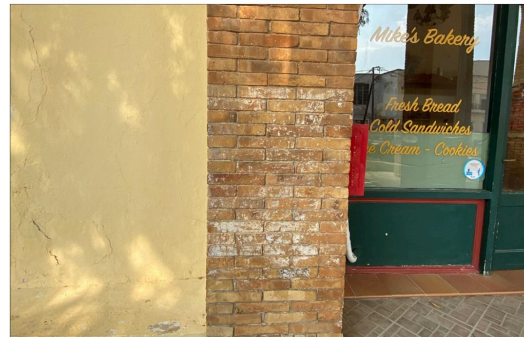
Figura 11: Efflorescenza, prospetto Ovest
