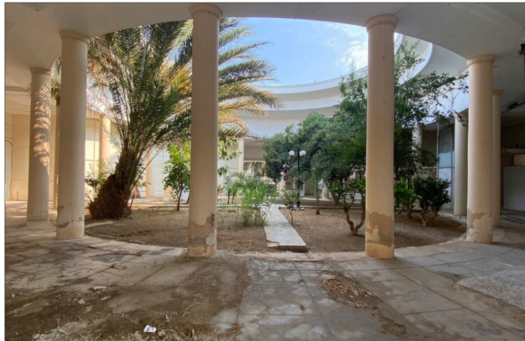
Figura 13: Erosione pavimento e distacco intonaco colonne interno cortile
