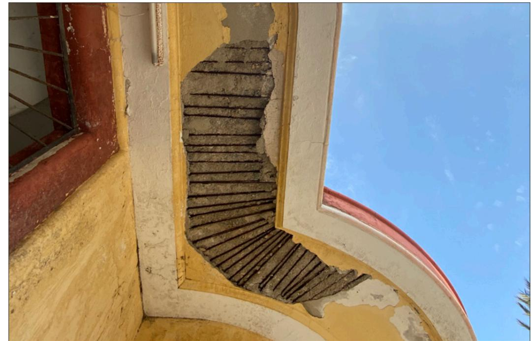
Figura 15: corrosione da cloruro, prospetto Sud
