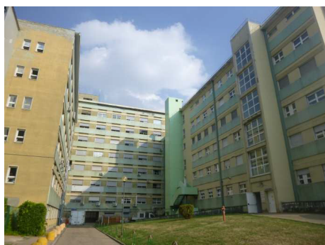
(a) Prospetto dell'edificio ospedaliero.
