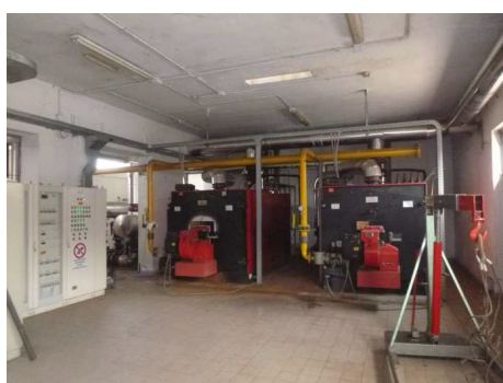
(c) Prospetto della centrale termica.
