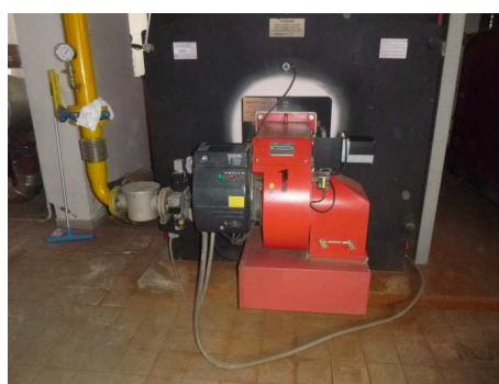
(d) Prospetto della centrale termica.
