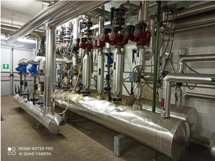
**Figura 49.** Dorsali di distribuzione dell'acqua calda prodotta da caldaia e PdC nella configurazione ex-post.
