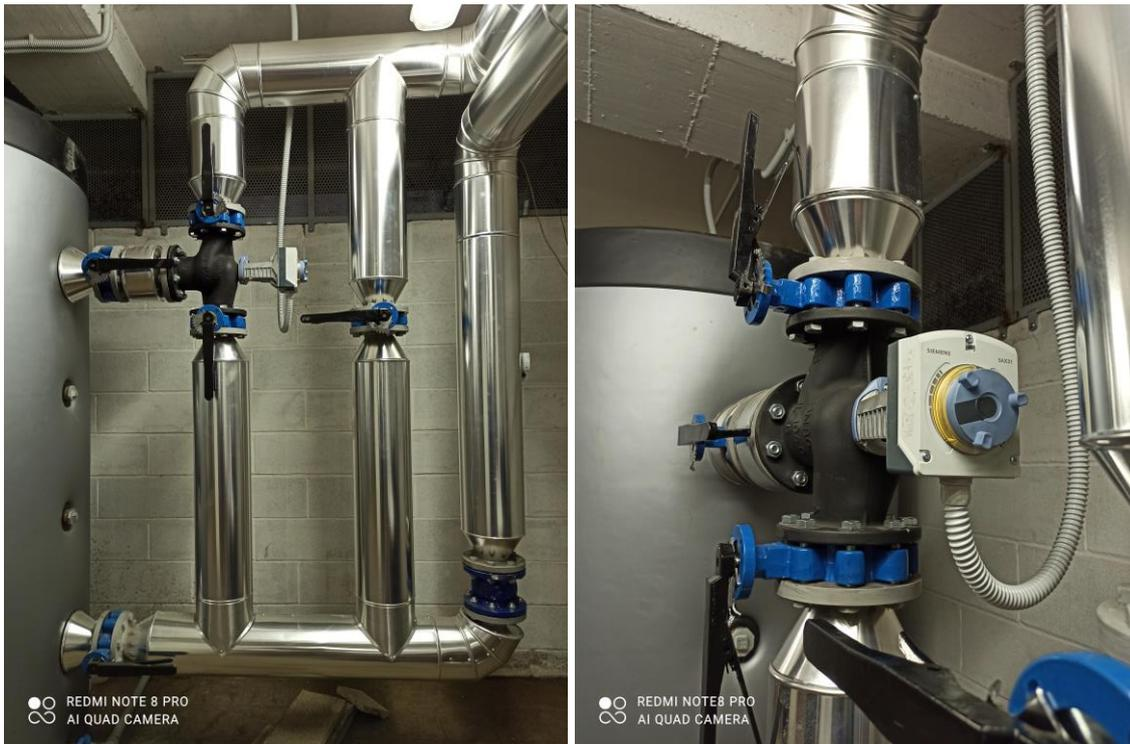
**Figura 50.** Valvola miscelatrice a tre vie, a valle dell'accumulatore inerziale.
