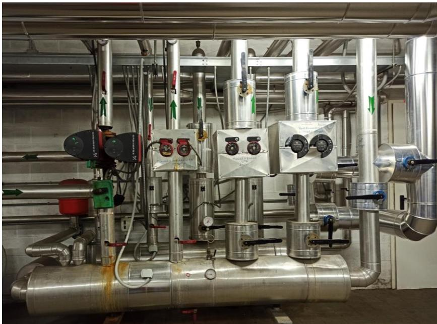
**Figura 23.** Dorsali di distribuzione dell'acqua refrigerata prodotta dai chiller nella configurazione ex-ante.
