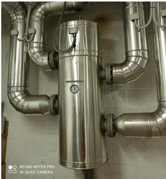
**Figura 21.** Separatore idraulico.
