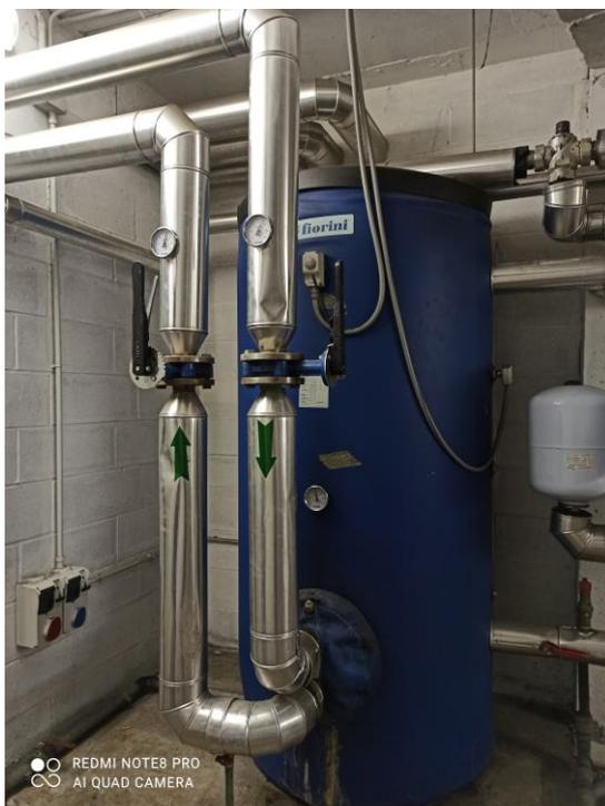
**Figura 26.** Accumulo di Acqua Calda Sanitaria.
