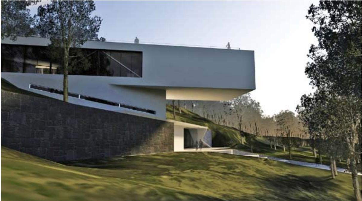
Puesto que la zona en proyección es bastante larga, el tercer nivel del museo es constituido por una estructura reticular, integrada en dos gordas soleras en hormigón armado. Ésta será formada por perfiles de acero, en particular vigas HEA orientadas en manera perpendicular respecto a la dirección del prolongamiento y una más grande orientada en diagonal para apoyarse al muro portante abajo en el segundo nivel.
