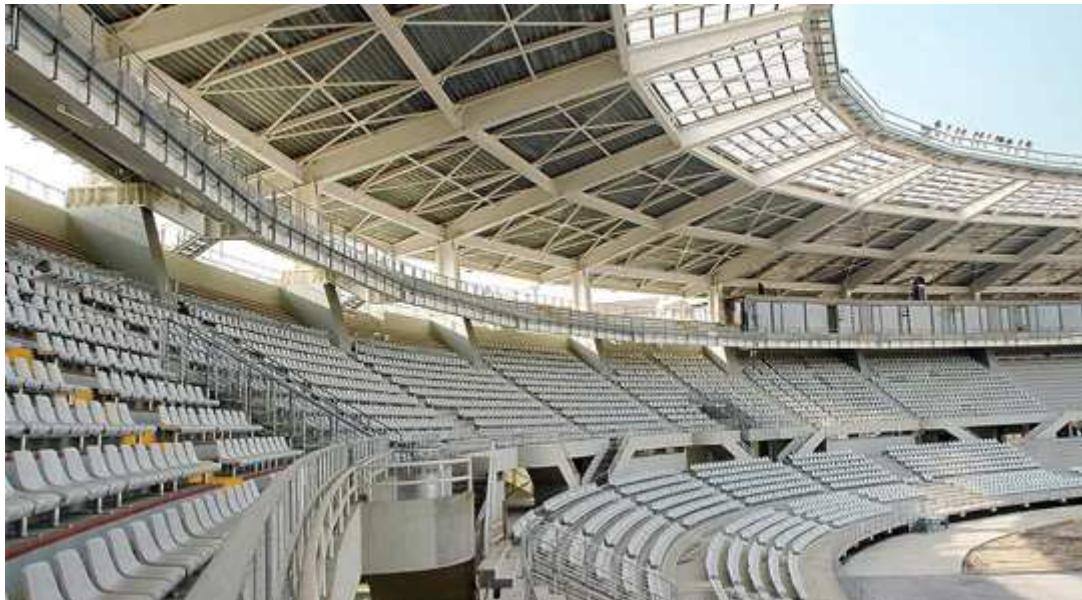
Figura 1-12 Ristrutturazione e nuova copertura metallica
