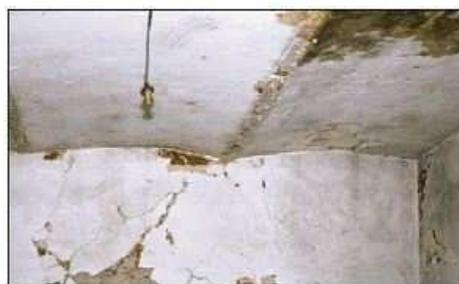
Solaio con travi di ferro a voltine.
