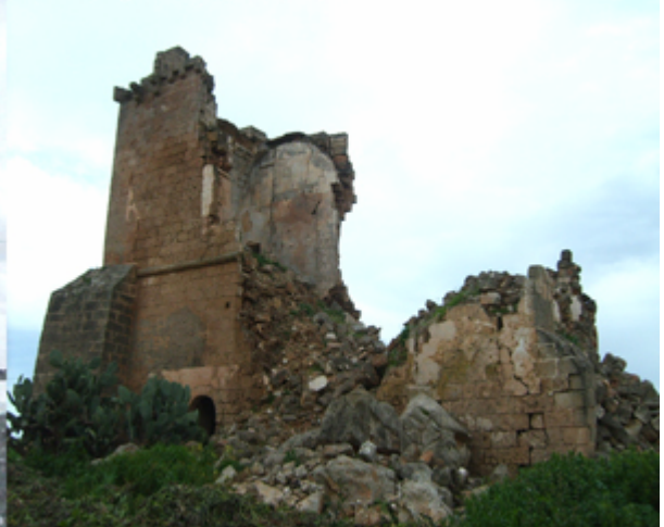
Sopralluogo stato di fatto febbraio 2009
