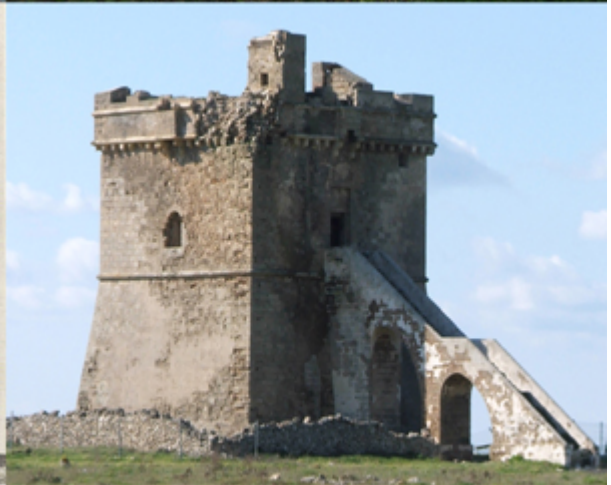
Sopralluogo stato di fatto maggio 2009
