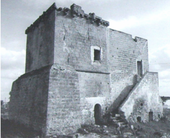
Sopralluogo stato di fatto 1980 (nota 1)
