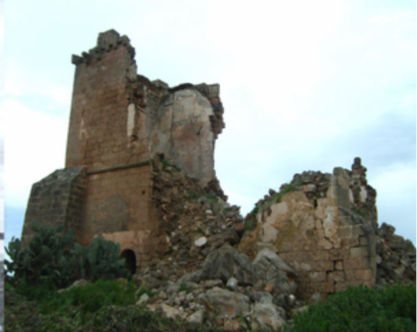
Sopralluogo stato di fatto febbraio 2009
