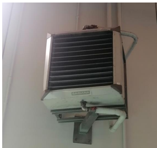
Figura 43: Aerotermo ad acqua
