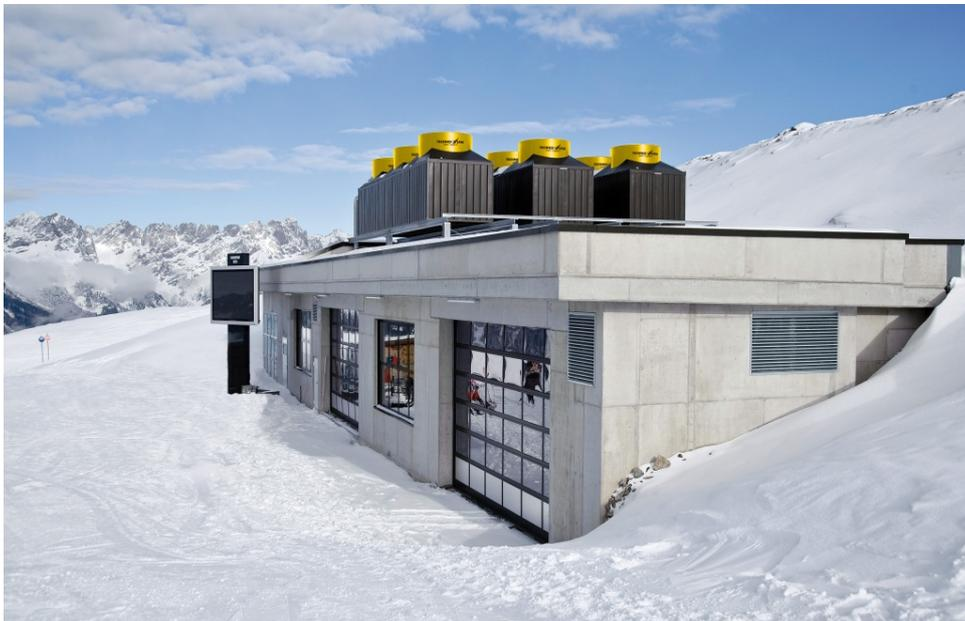
*Figura 18: In alto, sul tetto dell'edificio, è possibile osservare le torri di raffreddamento utilizzate per abbassare ulteriormente la temperatura dell'acqua.*
