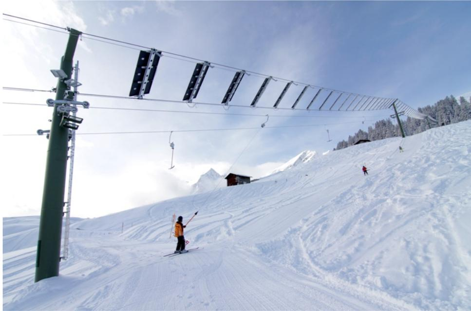
*Figura 33: Svizzera, primo impianto di risalita a funzionare a energia solare.*
