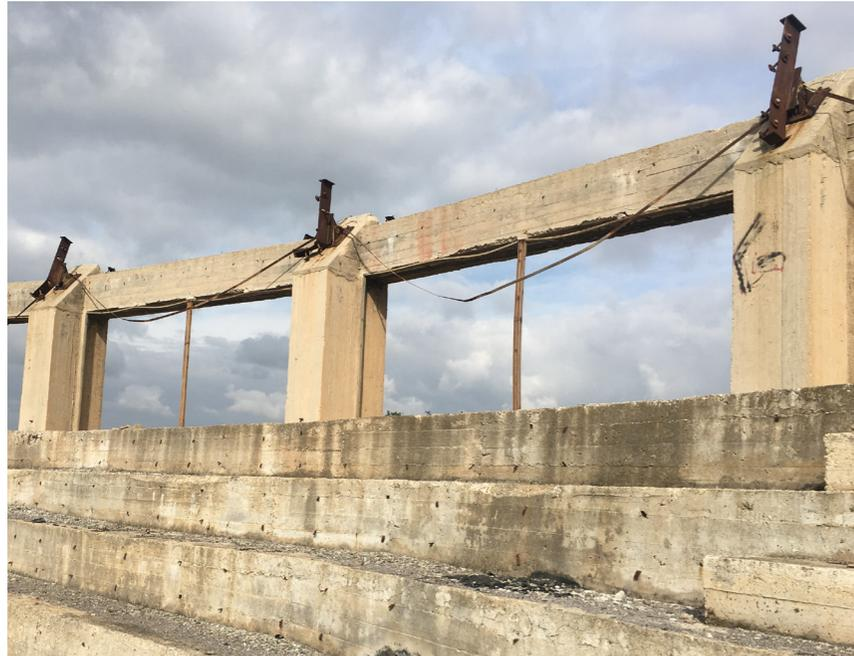
I degradi strutturali causano una rilevante perdita di materiale
