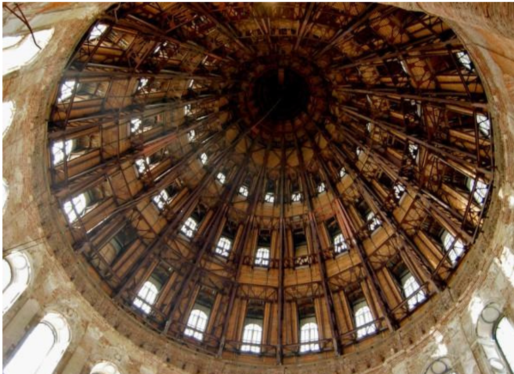
Figura 2b.10 (Parte I) - Fotografia degli interni della cupola in ferro, in: [20]
